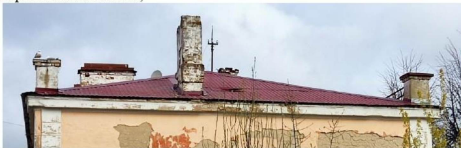
Тумбы на крыше Жилого дома
