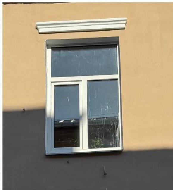
Оформление оконного проема юго-западного фасада
