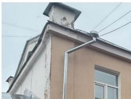
Тумбы на крыше Заводоуправления
