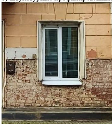
Оконные проемы первого этажа
