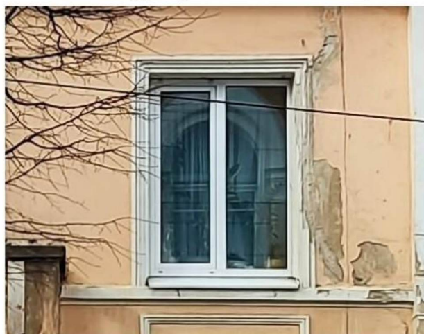
Оконные проемы второго этажа
