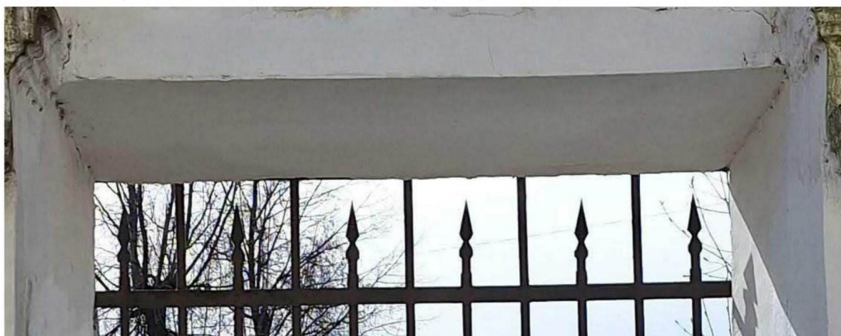
Перемычка проема пилон примыкающего к пряслу в середине ограды
