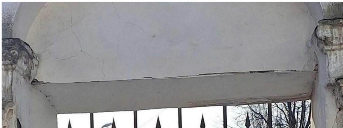
Перемычка проема пилон примыкающего к пряслу в северо-восточной части ограды
