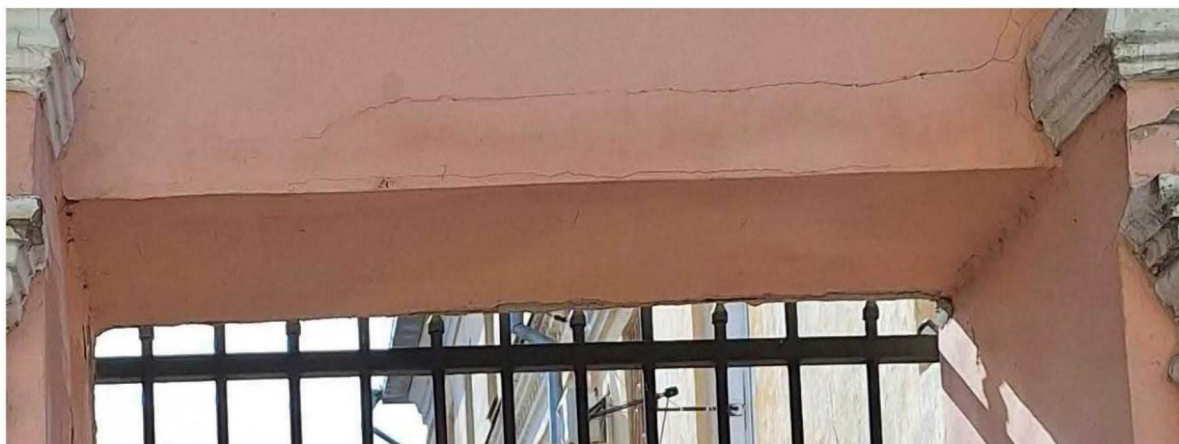
Перемычка проема пилон примыкающего к пряслу в юго-западной части ограды
