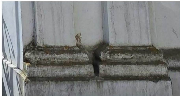
Профилированные базы пилястр (со стороны северо-западного фасада)
