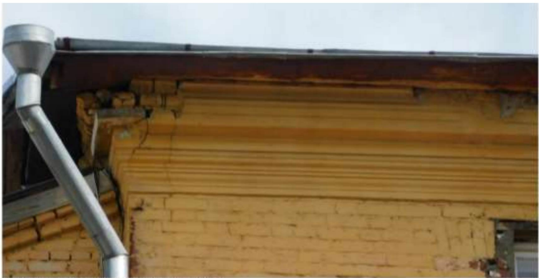
Венчающий карниз восточной пристройки
