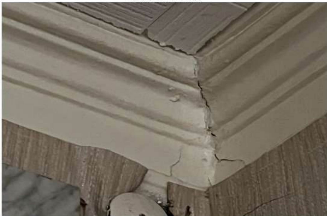
Профилированный потолочный карниз помещения 2-го этажа
