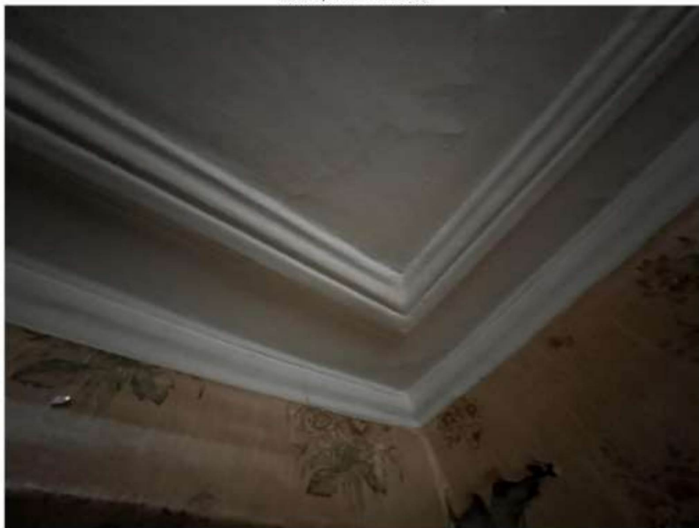
Профилированный потолочный карниз помещения 1-го этажа
