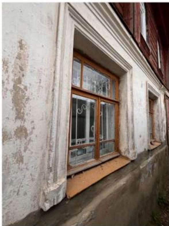
Профилированный тянутый наличник проемов 1-го этажа
