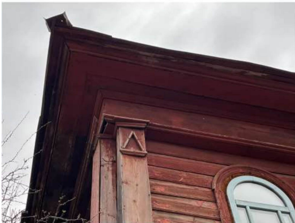
Венчающий карниз с широкой фризовой доской. Доски-лопатки
