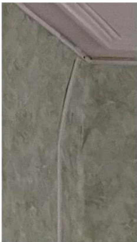
Профилированный потолочный карниз помещения 2-го этажа
