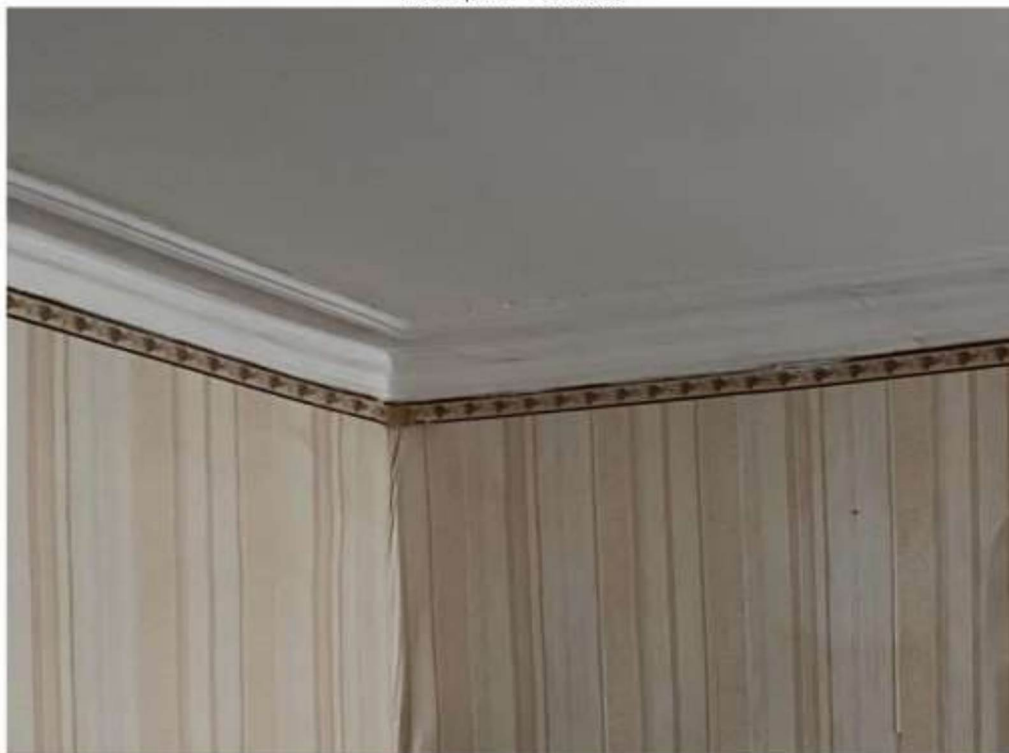
Профилированный потолочный карниз помещения 1-го этажа
