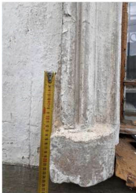
Профилированный тянутый наличник проемов 1-го этажа
