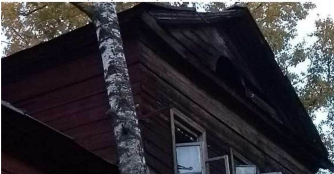
5.5 Местоположение профилированного венчающего карниза по основному объёму здания и мезонину;
