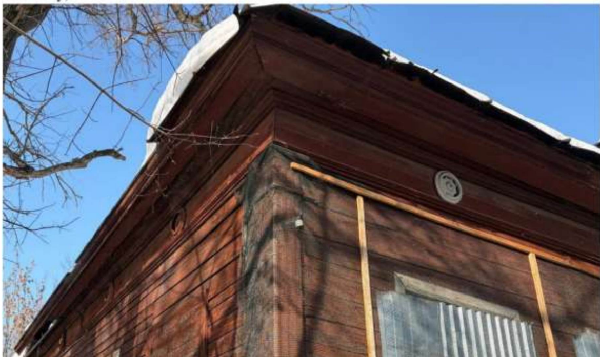
5.5 Местоположение профилированного венчающего карниза по основному объёму здания и мезонину;
