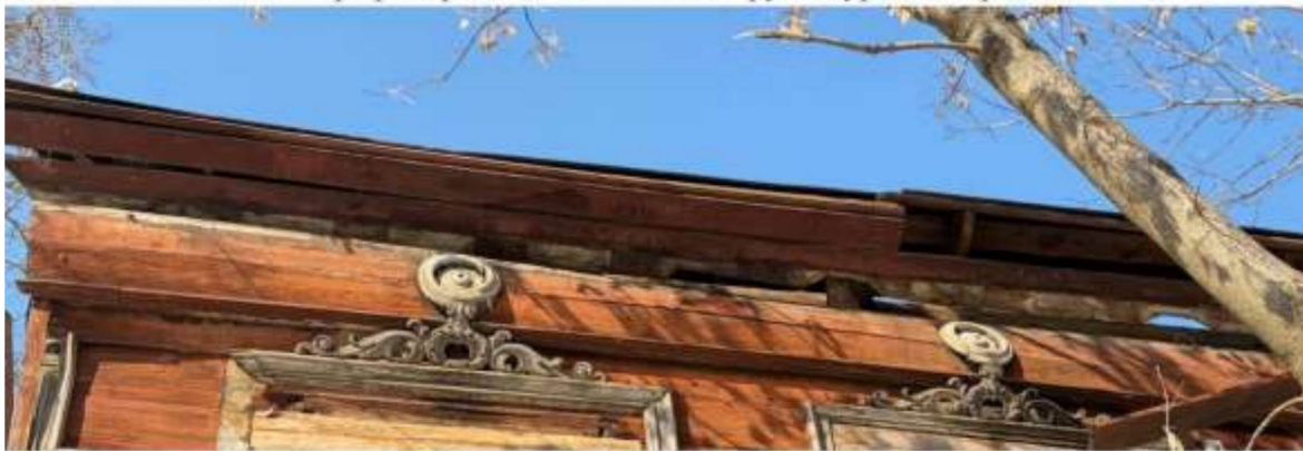
5.4 Местоположение гладкого фриза мезонина с профилированной полочной в нижней части по юго-западному, северо-западному, северо-восточному фасадам;
