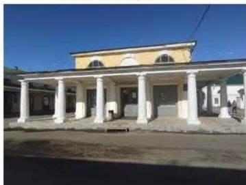
Фото № 1. Общий вид со стороны юго-восточного фасада
