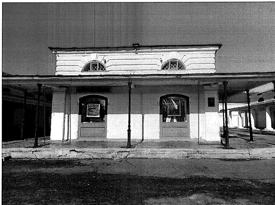
Фото 1. Общий вид со стороны юго-восточного фасада.
