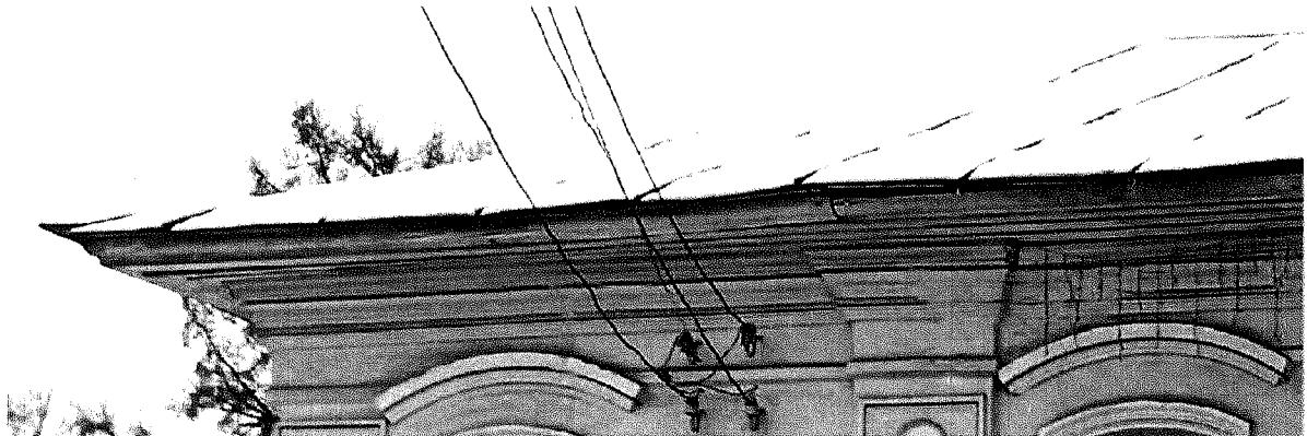
Мелкопрофилированный междуэтажный карниз по главному (северо-восточному) фасаду; наливные и местоположение междуэтажного карниза по северо-западному фасаду;
