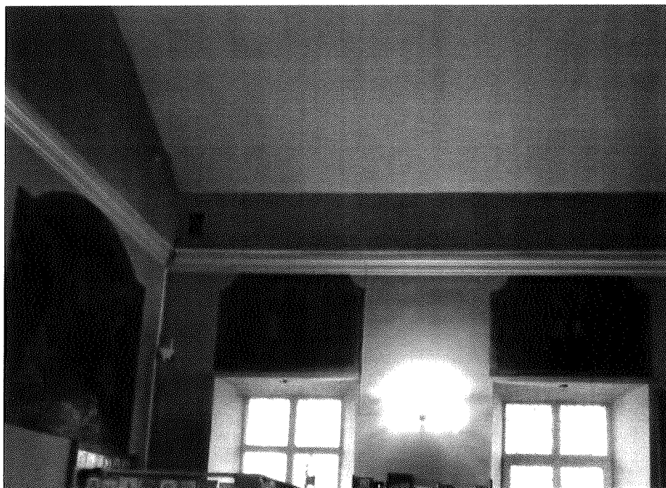
Штукатурные тяги в основании свода трапезной
