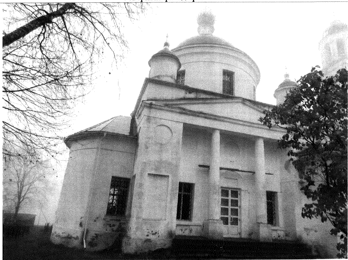
Портик четверика северного фасада
