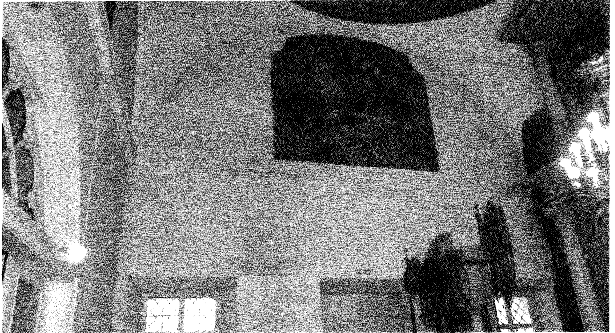
Штукатурные тяги в основании парусов четверика
