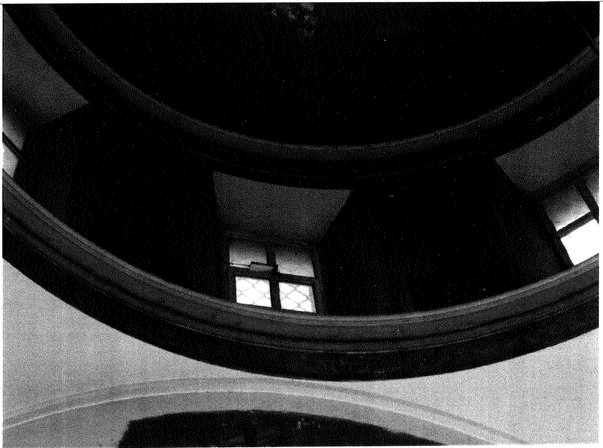
Штукатурные тяги в основании купола и стен ротонды
