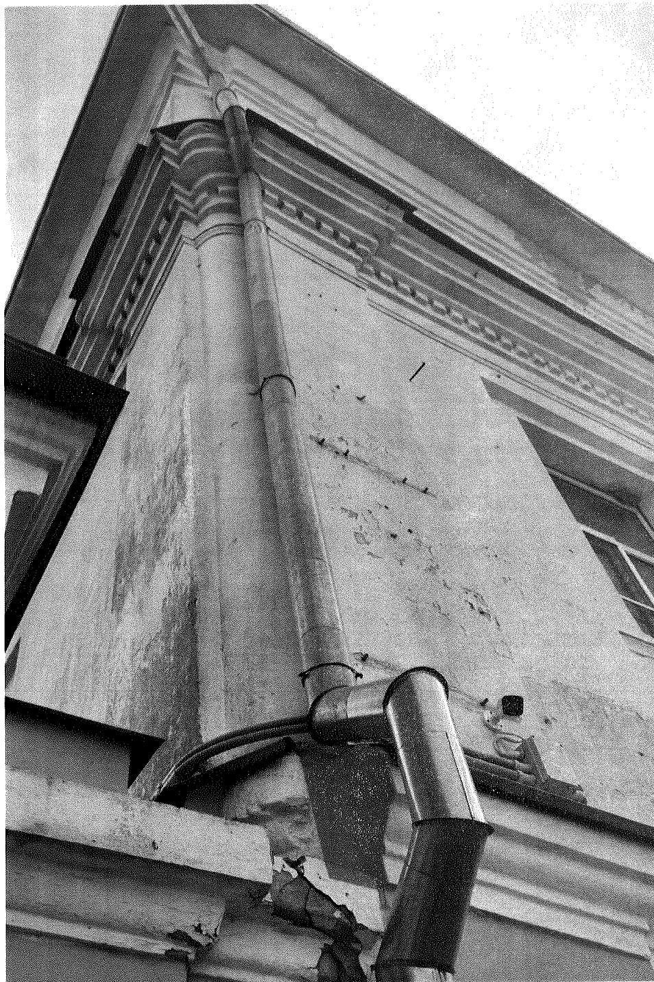
Угловое решение главного фасада
