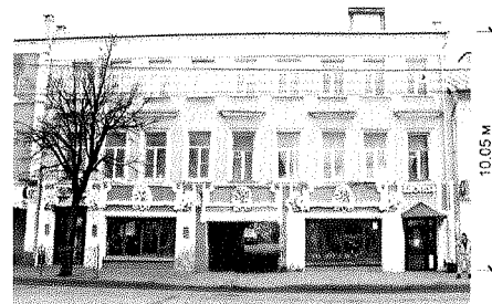
Юго-западный фасад (фрагмент)
