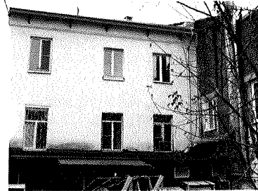
Северо-восточный фасад (основной объем) фрагмент
