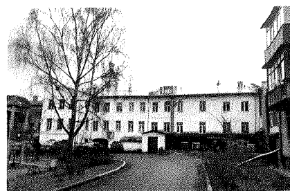
Общий вид с севера
