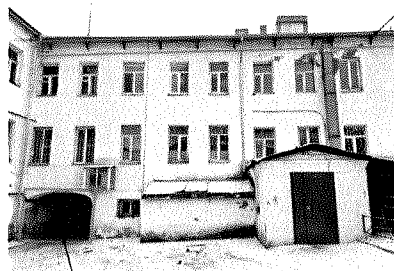
Северо-восточный фасад (основной объем) фрагмент
