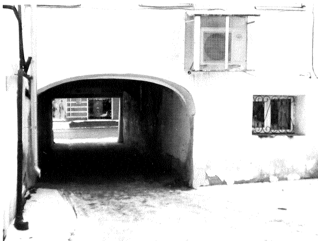
Фрагмент северо-восточного фасада
