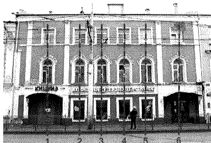
Юго-западный фасад (левая часть)
