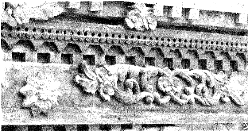
Детали венчающего карниза мезонина главного фасада. Резные элементы фриза с мотивами растительного орнамента.
