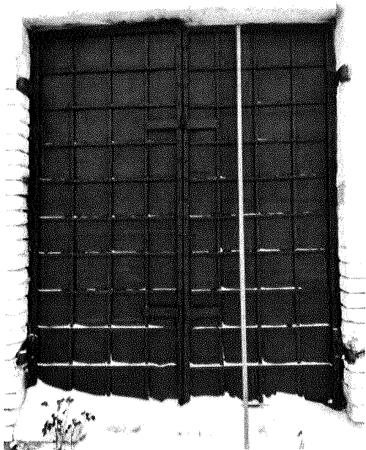
Двухстворчатые металлические ставни на металлических маклаках в проемах первого этажа по левому флангу юго-восточного фасада. Фото 2023 г.
