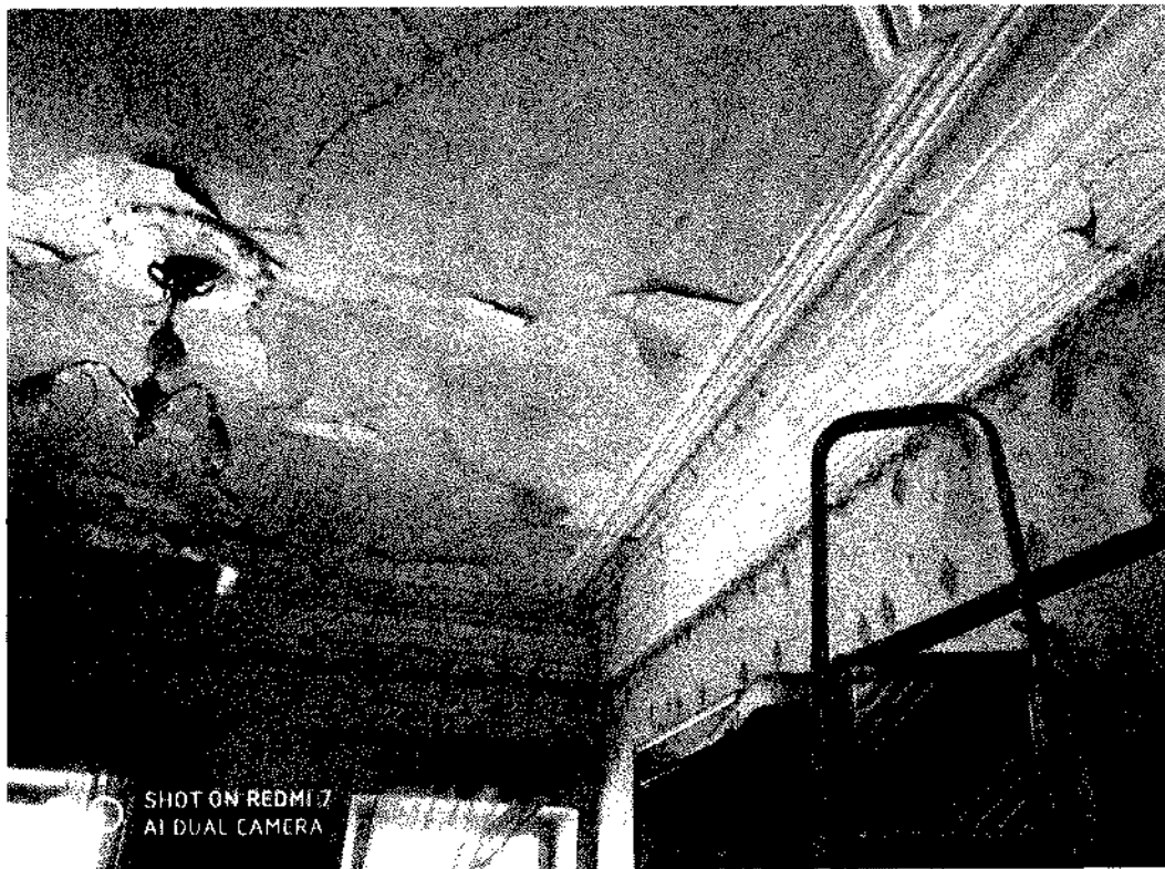
Местоположение тянутых потолочных карнизов в помещениях второго этажа (Тип6).
