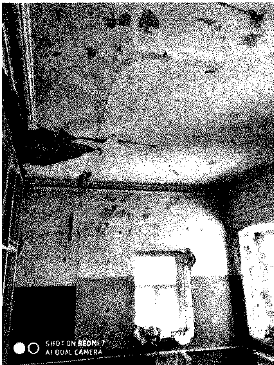
Местоположение тянутых потолочных карнизов в помещениях второго этажа (Тип4).
