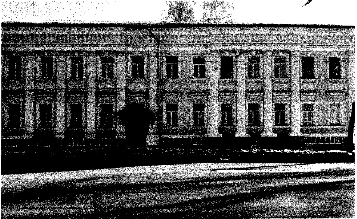
Выступающий цоколь северо-западного фасада (объем №2), низкие оконные проемы подвалов отмечены рустом
