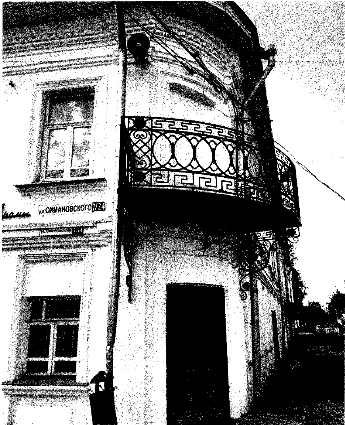
Многообломный венчающий карниз с поясом «сухариков», многообломный межэтажный карниз, профилированный тянутый наличник ниши 2-го этажа, оформление стукowymi профилированными наличниками оконных проемов 1-го и 2-го этажей (Объем №1)
