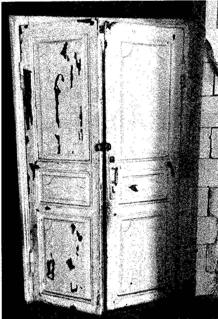
Заполнение дверных проемов второго этажа
