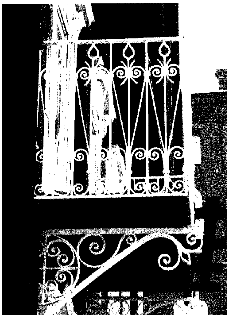
Кованый кронштейн балкона.
