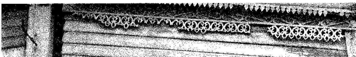
Резной фриз дворовой пристройки.
