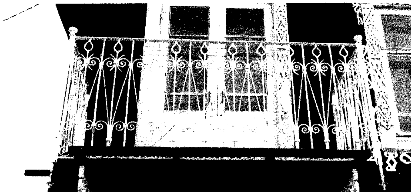
Кованое ограждение балкона.
