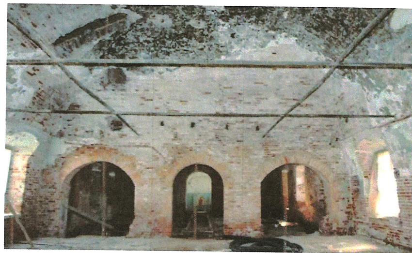
Фото 39. Арочные проемы между помещениями трапезной и четверика. Фото 2020г.
