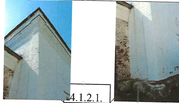
Фото 9. Пилястры восточного фасада четверика Фото 2020г.
