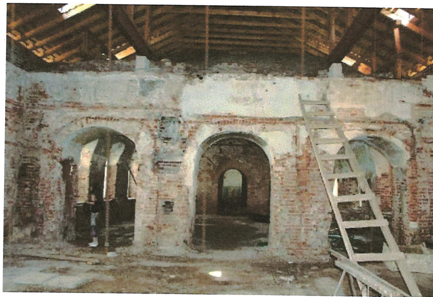
Фото 38. Арочные проемы между помещениями трапезной и притвора. Фото 2020г.
