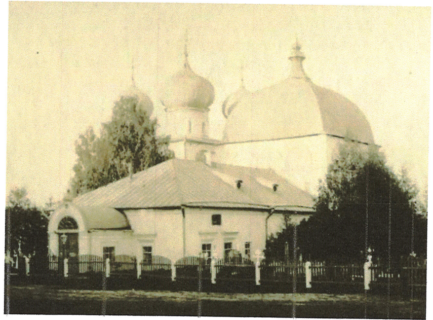
Фото 2. Южный и западный фасады. Слуховые окна южного ската кровли трапезной и притвора. Фото XIXв. КОКМ
