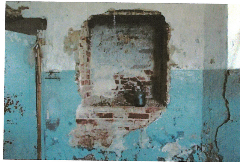
Фото 49. Ниша в северной стене апсиды. Фото 2020г.
