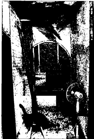
половине – с коробовыми сводами. В подвале – стена, разделяющая его на восточную и западную половины, перекрытые цилиндрическими сводами с распалубками и связанные арочными проемами.
