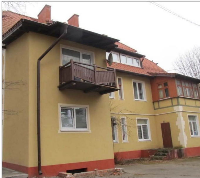
Фото 3, 4. Юго-западный фасад Памятника.
