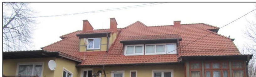
Фото 17. Юго-восточный скат крыши.
