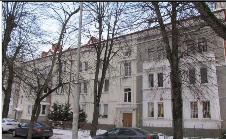
Фото 5. Вид с юго-востока, южный объем, южный фасад.
