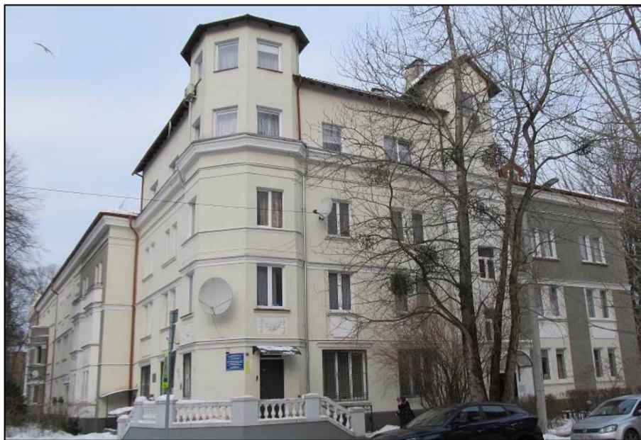
Фото 2. Вид с юго-востока, южный фасад южного объема, восточный фасад восточного объема.
