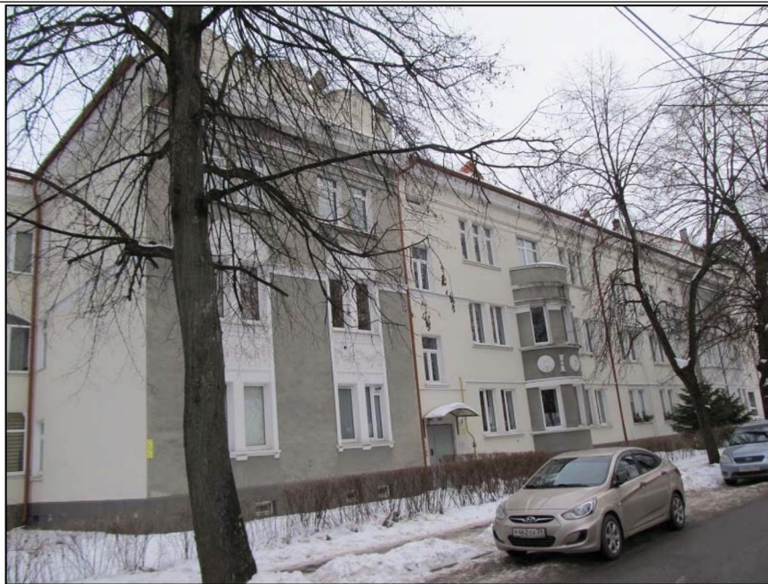
Фото 4. Вид с юго-запада, южный объем, южный фасад.
