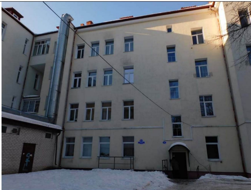
Фото 8. Фасад № 4. Фрагмент фасада слева от ризалита.
