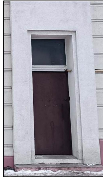
Фото 12. Дверной проем входа на фасаде № 2.
