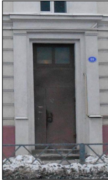
Фото 11. Дверной проем входа на фасаде № 1.
