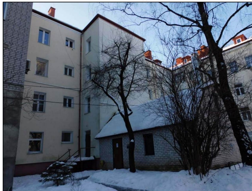
Фото 11. Фасад № 5, фрагмент фасада слева от ризалита.
