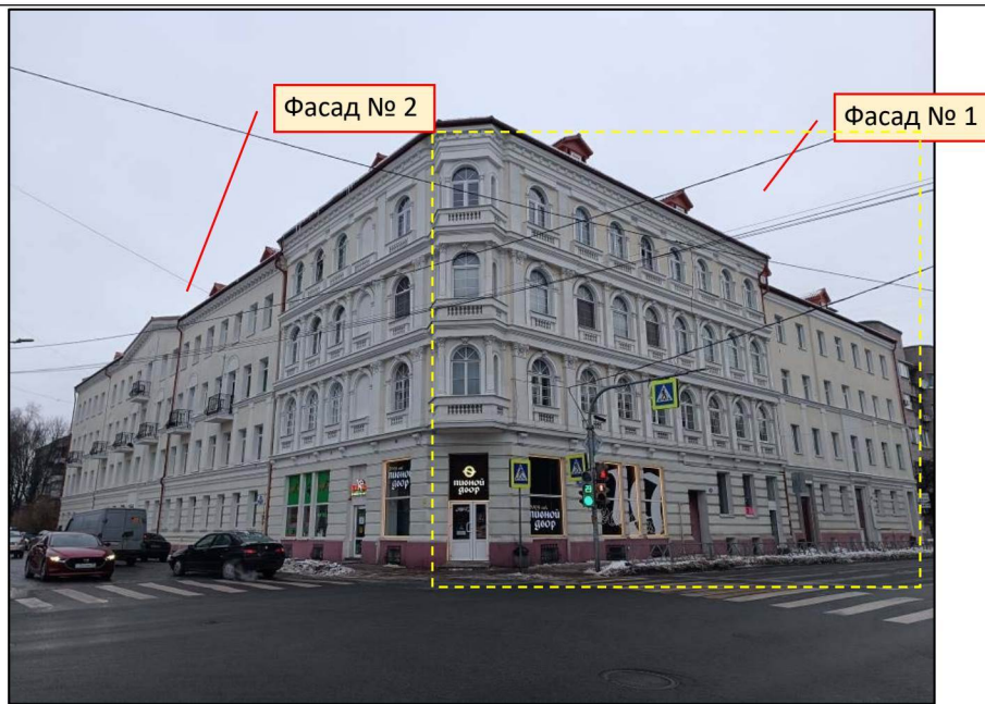
Фото 1. Общий вид Памятника с юго-запада. Фасады № 1, № 2.
