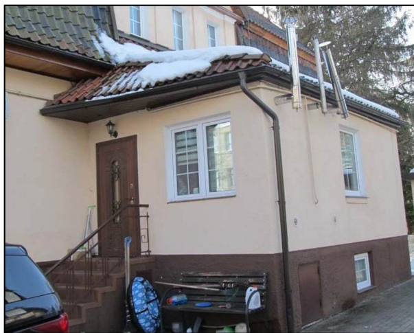
Фото 8. Тамбур, северный и восточный фасады.
