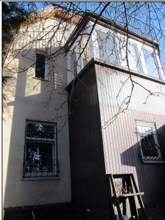
Фото 7. Западный фасад основного объема.
