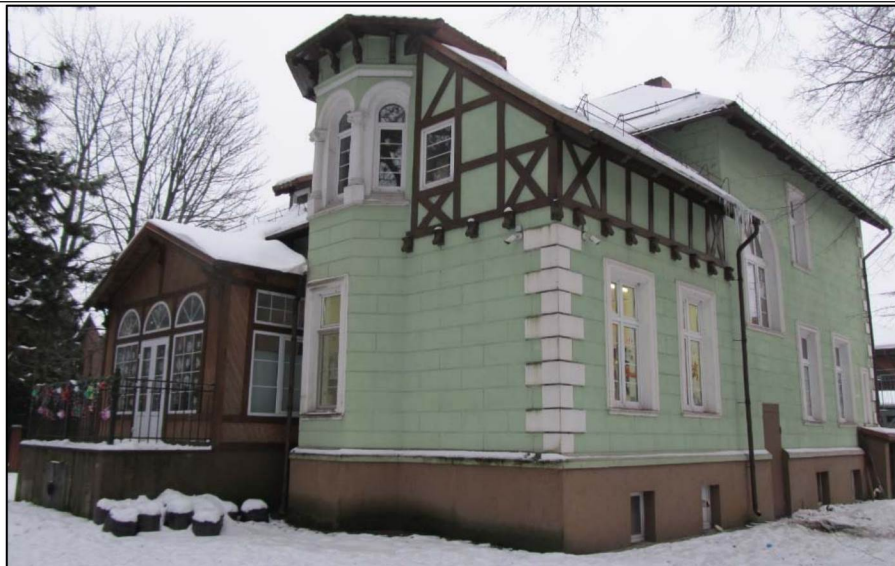
Фото 2. Вид с северо-запада, северный и западный фасад Памятника
