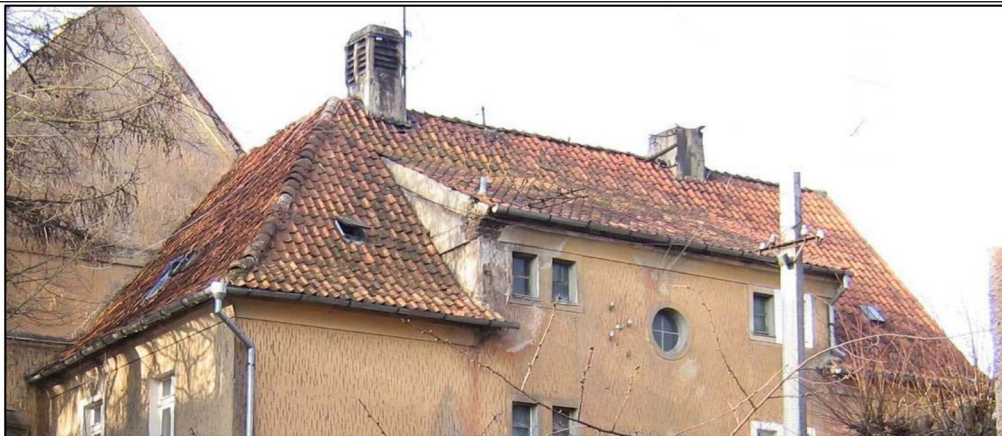
Фото 13. Восточный и северный скаты крыши.
