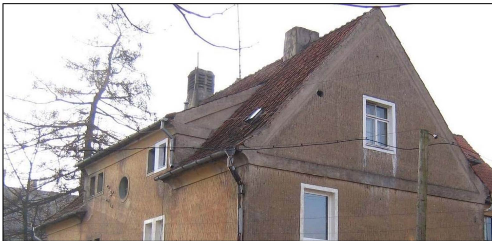
Фото 14. Северный скат крыши и щипцовый фронтон западного фасада.
