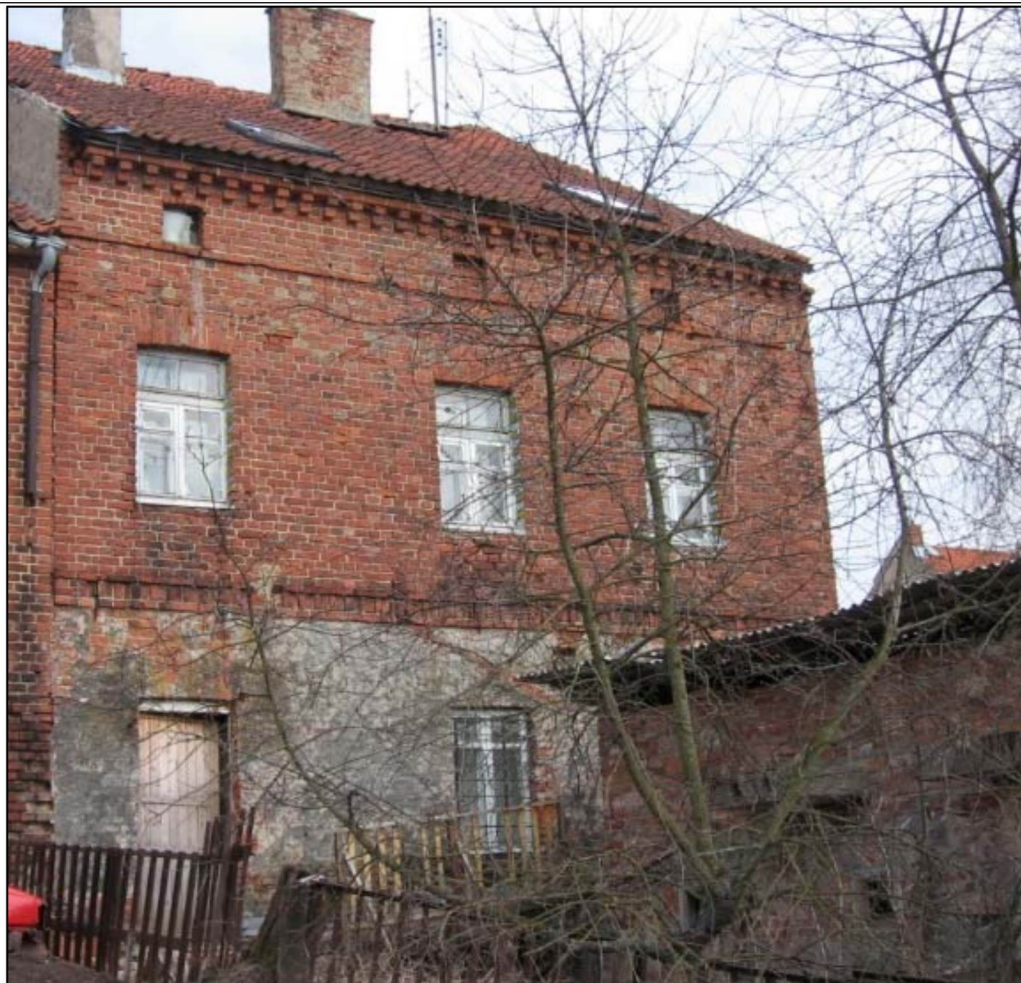
Общий вид Памятника с запада. Западный фасад.
