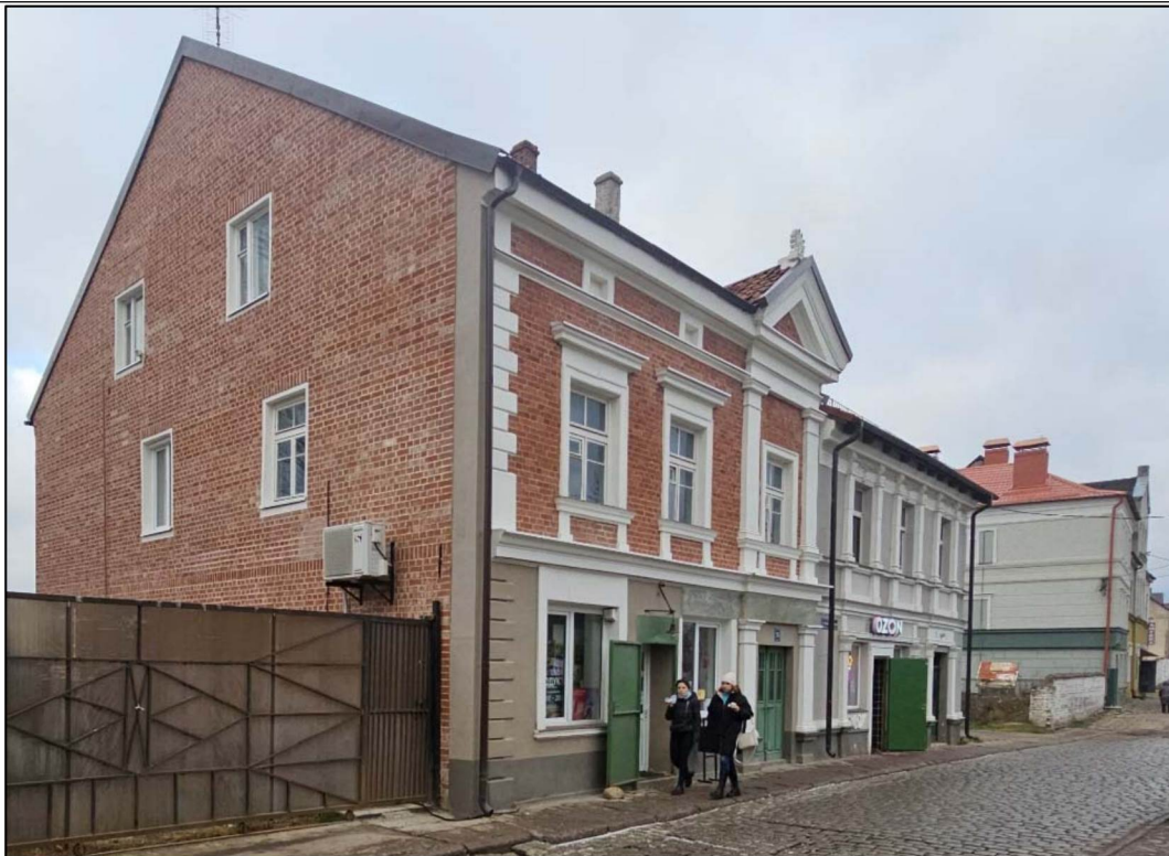
Общий вид Памятника с юго- востока. Восточный и южный фасад.
