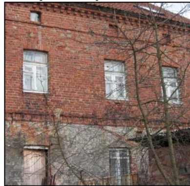
Оконные проемы первого, второго этажей и мансарды западного фасада
