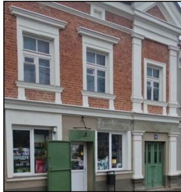
Оконные проемы первого, второго этажей восточного фасада.
