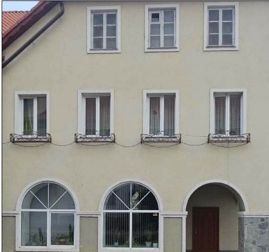
Фото 4. Оконные проемы первого, второго и третьего этажей восточного фасада
