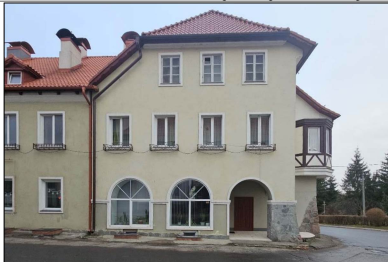
Фото 2. Общий вид Памятника с востока. Восточный главный фасад.
