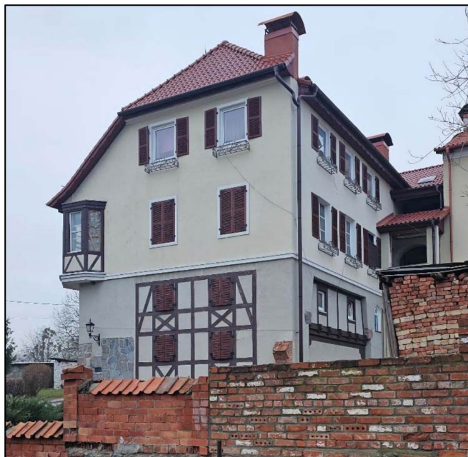
Фото 7. Западный фасад Памятника.
