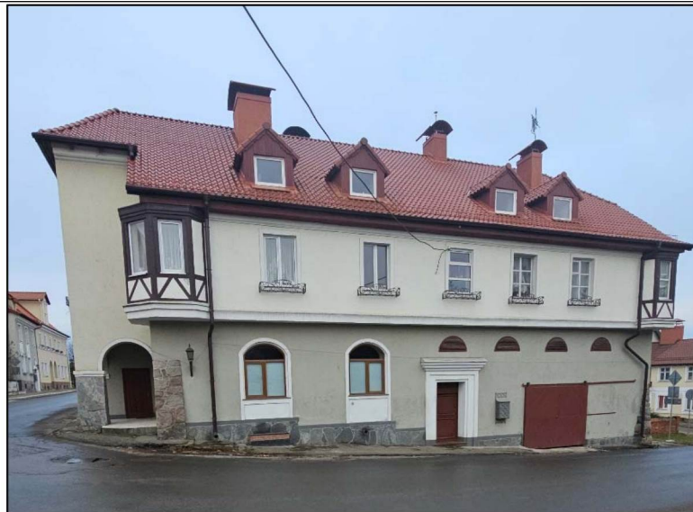
Фото 1. Общий вид Памятника с севера. Северный главный фасад.
