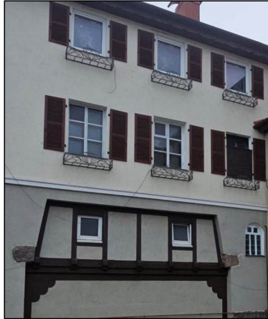
Фото 6. Оконные проемы южного фасада.
