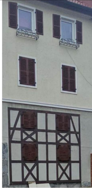
Фото 5. Оконные проемы на западном фасаде.
