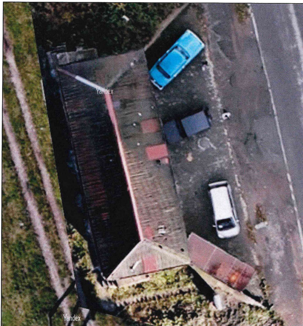
Крыша. Вид сверху.
