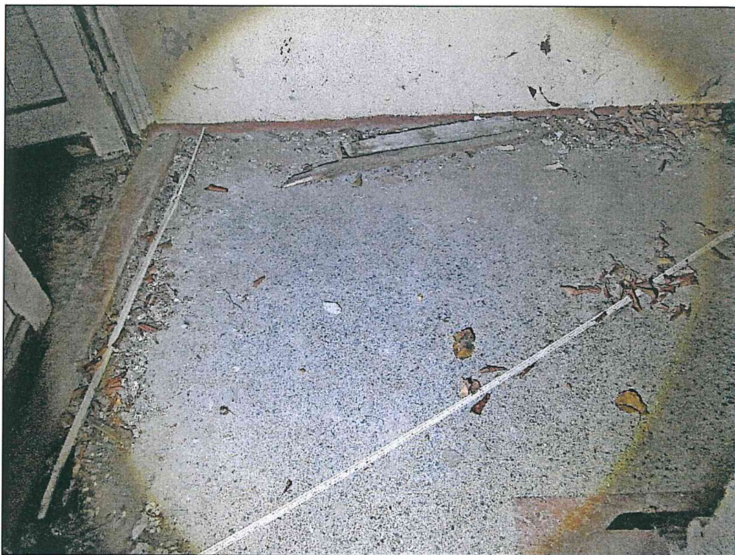
Фото 58. Первый этаж. Конструкции стен, перекрытий. Конструкции пола лестничной клетки.
