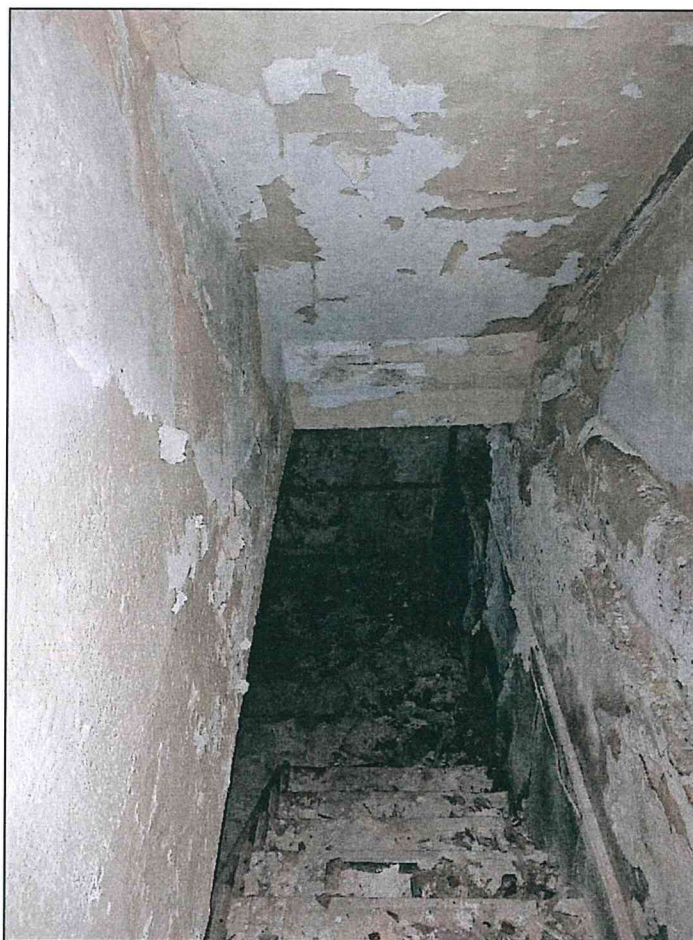
Фото 42. Подвал. Конструкции стен, перекрытий. Конструкции лестницы в подвал.
