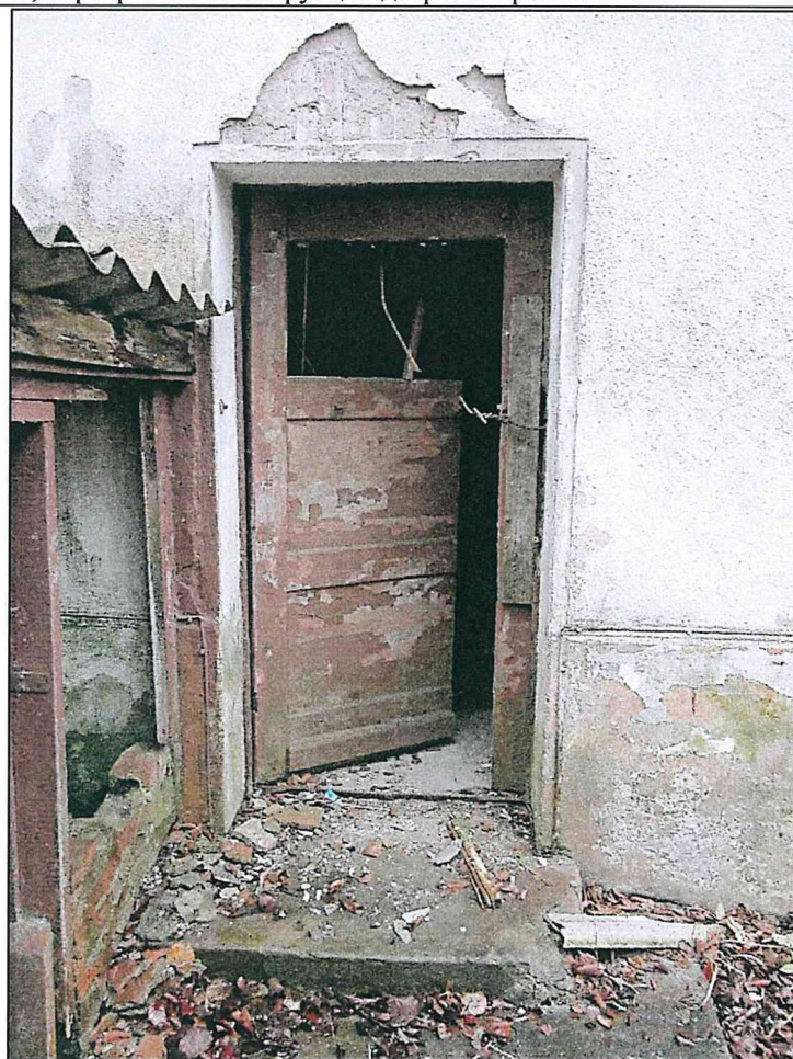
Фото 55. Первый этаж. Фасад № 3 – дворовый вход.
