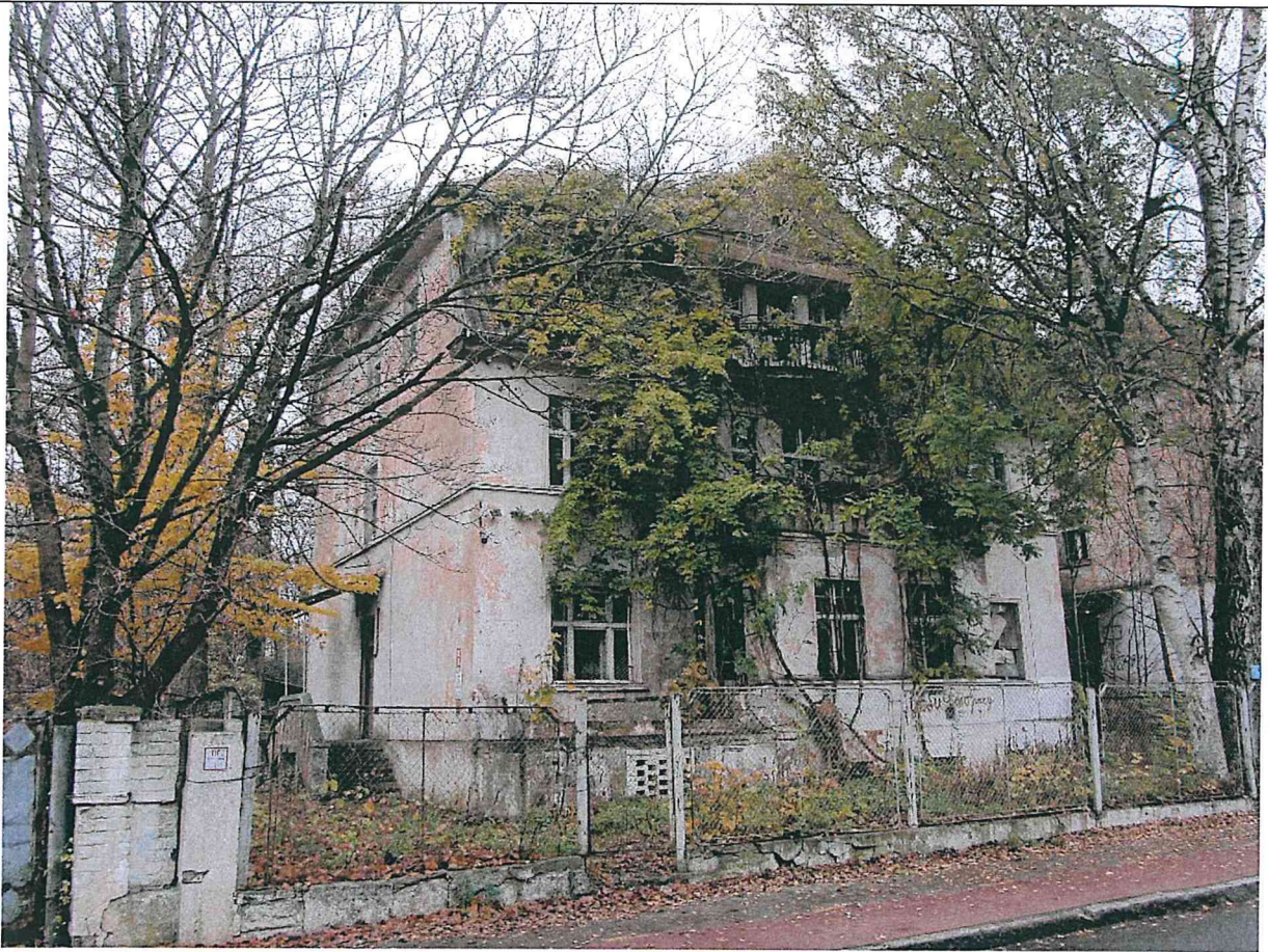
Фото 2. Общий вид. Проход.
