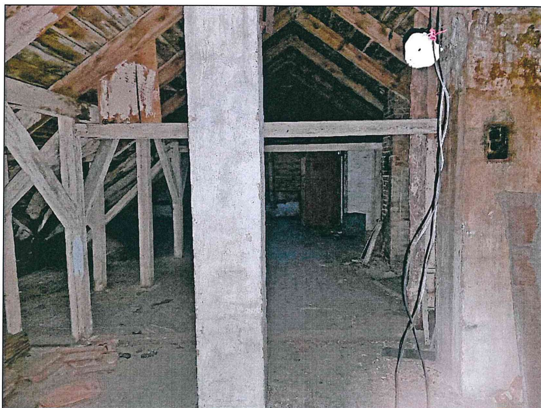
Фото 83. Чердак. Конструкции стропильной системы крыши. Конструкции вентиляционных, печных каналов.
