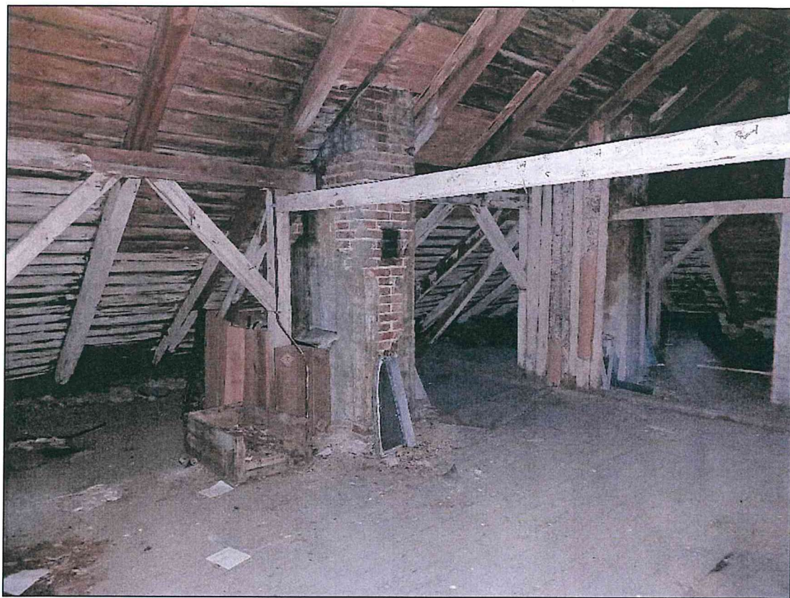
Фото 82. Чердак. Конструкции стропильной системы крыши. Конструкции вентиляционных, печных каналов.
