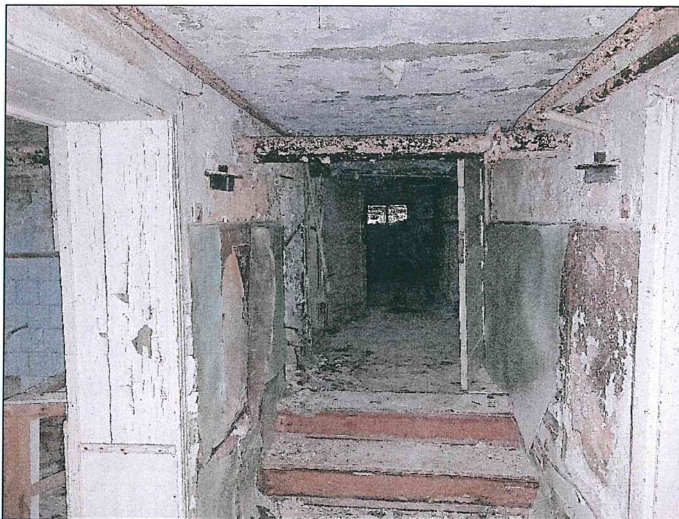
Фото 54. Подвал. Конструкции стен, перекрытий. Конструкции дверных проемов.
