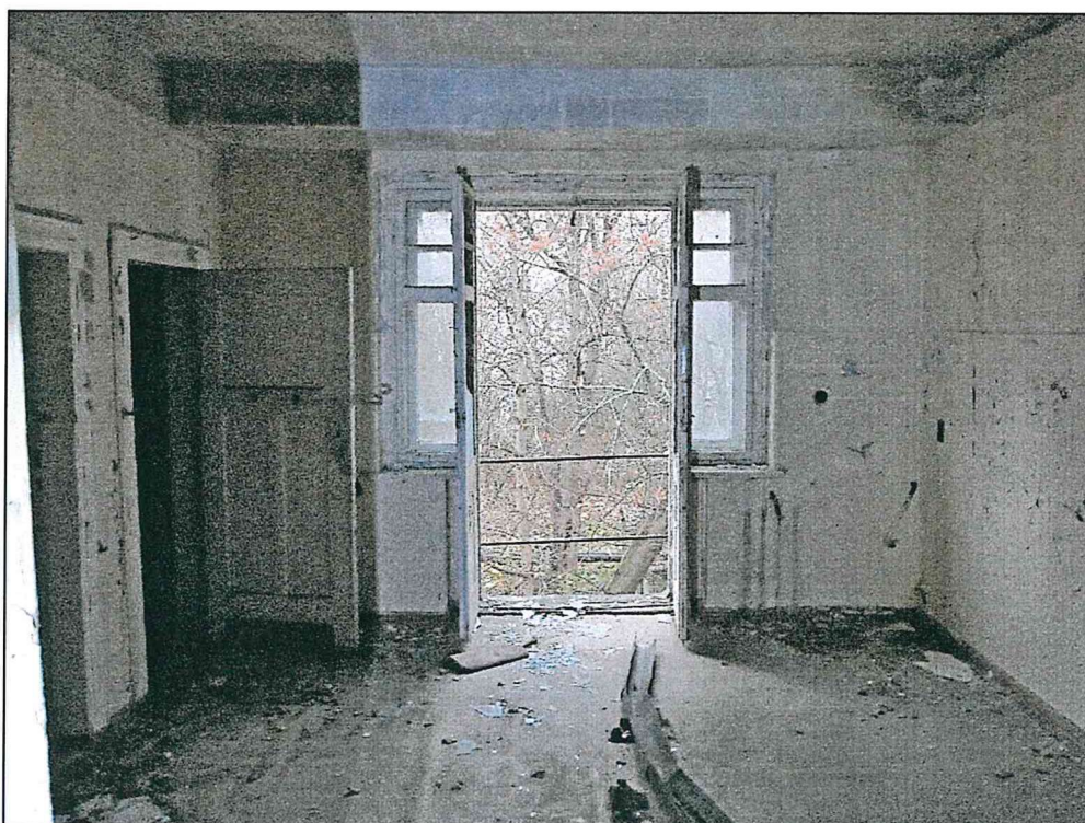
Фото 75. Третий этаж. Конструкции стен, перекрытий. Дверной проем на фасаде № 3 в уровне третьего этажа – выход на балкон третьего этажа. Конструкция оконных заполнений, дверного заполнения выхода на балкон.
