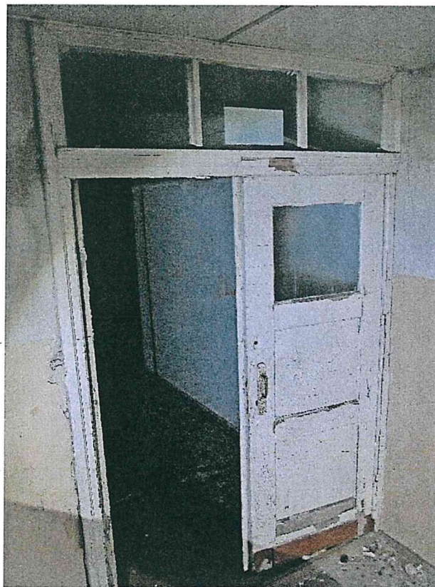
Фото 74. Третий этаж. Конструкции стен, перекрытий. Дверной проем входа во внутренние помещения третьего этажа. Конструкция дверного заполнения.
