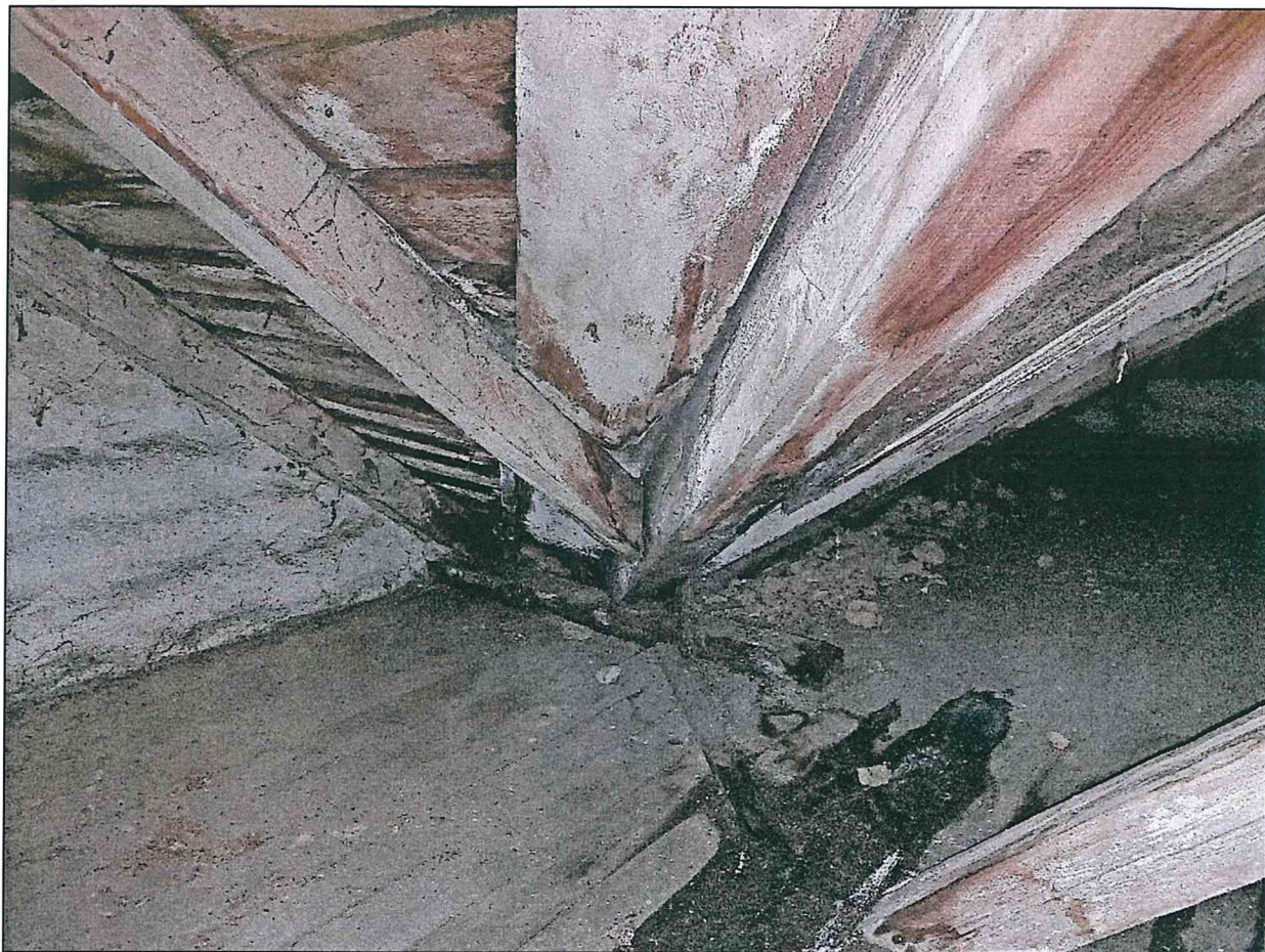
Фото 86. Чердак. Конструкции стропильной системы крыши.
