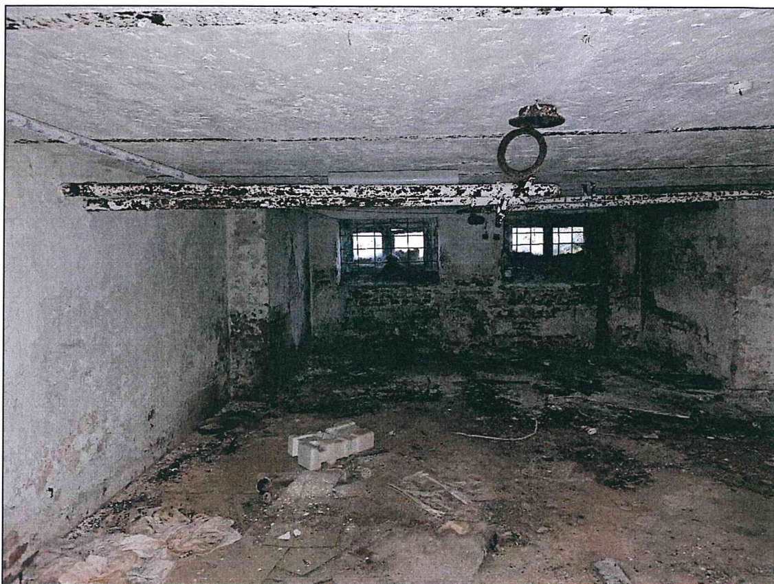
Фото 47. Подвал. Конструкции стен, перекрытий. Конструкции оконных проемов.
