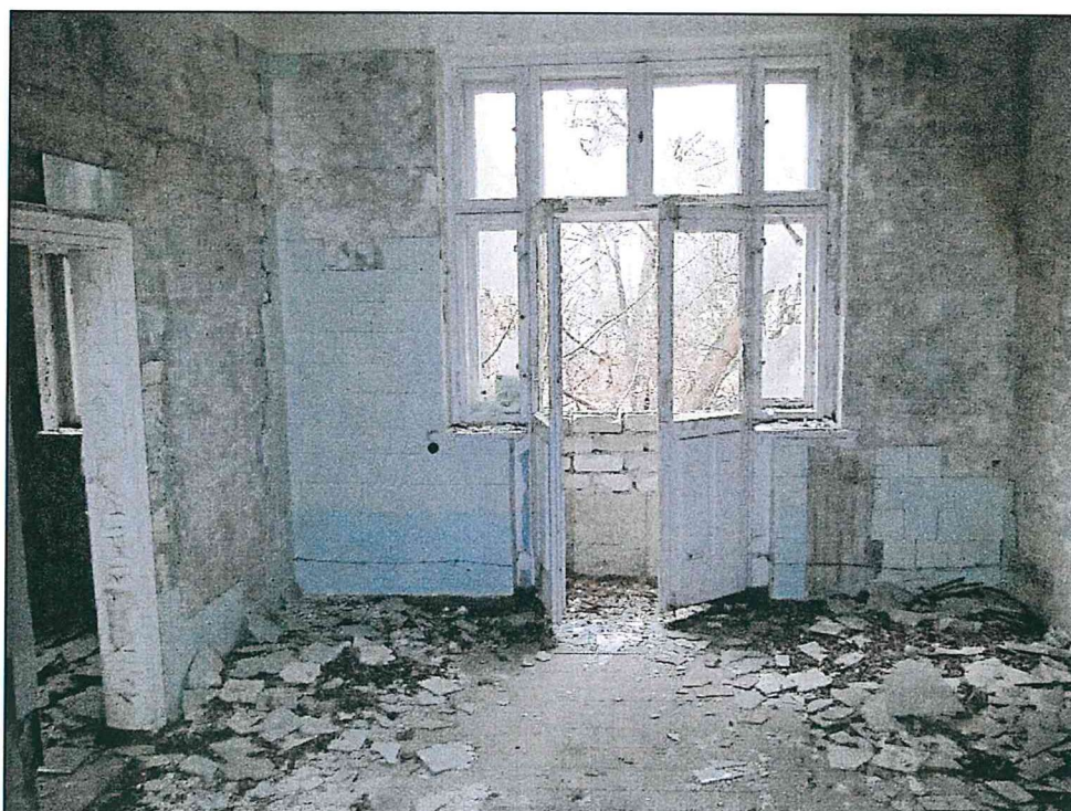
Фото 67. Второй этаж. Конструкции стен, перекрытий. Дверной проем на фасаде № 3 в уровне второго этажа – выход на балкон второго этажа. Конструкция оконных заполнений, дверного заполнения выхода на балкон.
