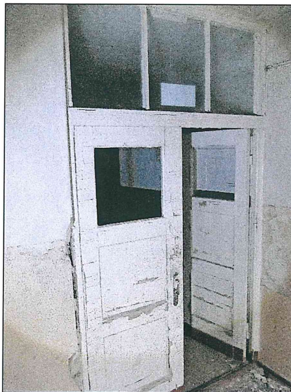
Фото 66. Второй этаж. Конструкции стен, перекрытий. Дверной проем входа во внутренние помещения второго этажа. Конструкция дверного заполнения.
