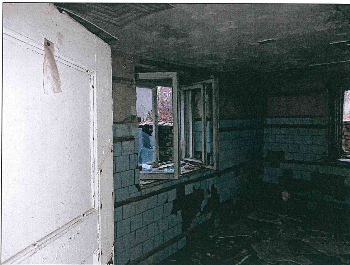
Фото 49. Подвал. Конструкции стен, перекрытий. Конструкции оконных проемов. Конструкции углового примыкания фасадов № 1, № 2.
