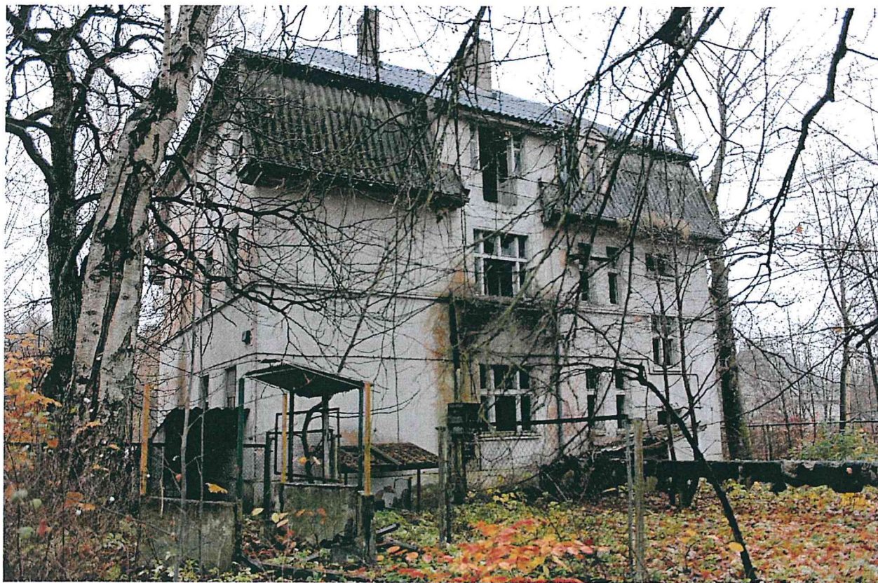
Фото 5. Общий вид. Внутренний двор.
