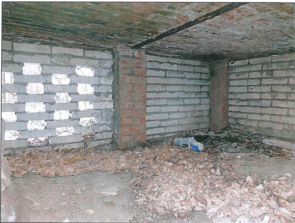
Фото 46. Конструкции террасы 1 этажа.
