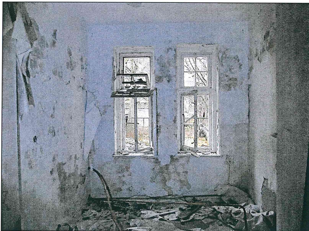
Фото 61. Первый этаж. Конструкции стен, перекрытий. Конструкции оконных заполнений.
