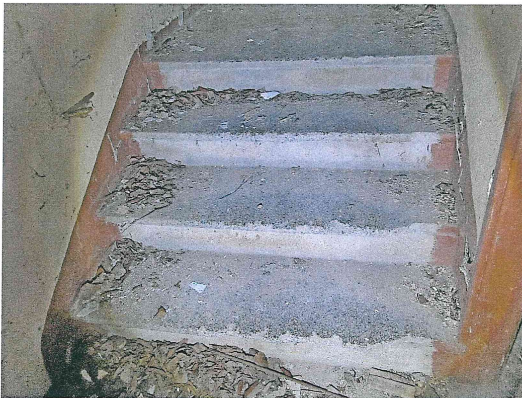
Фото 56. Первый этаж. Конструкции стен. Конструкции лестницы на первый этаж.
