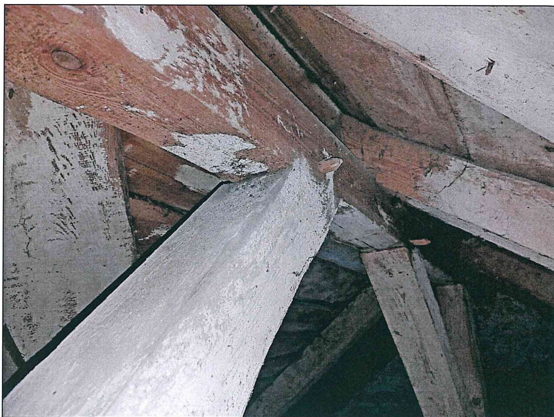
Фото 85. Чердак. Конструкции стропильной системы крыши.
