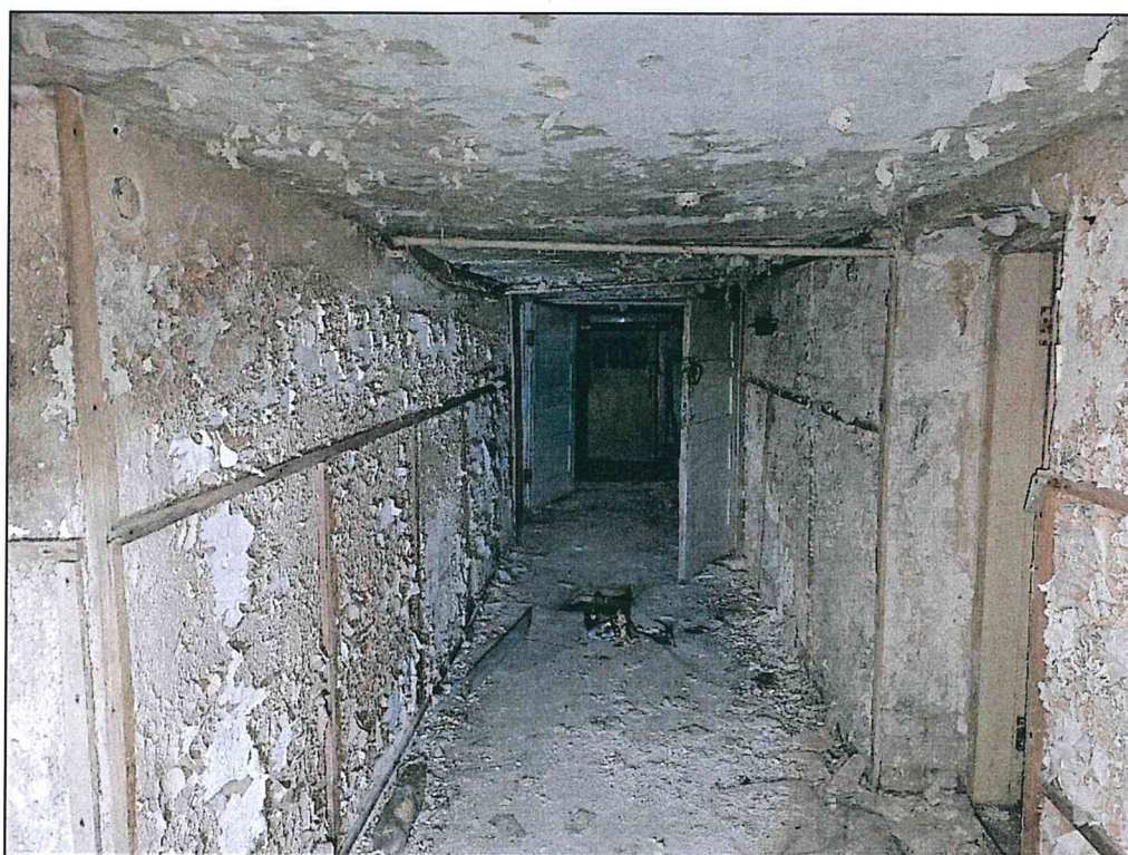
Фото 43. Подвал. Конструкции стен, перекрытий.
