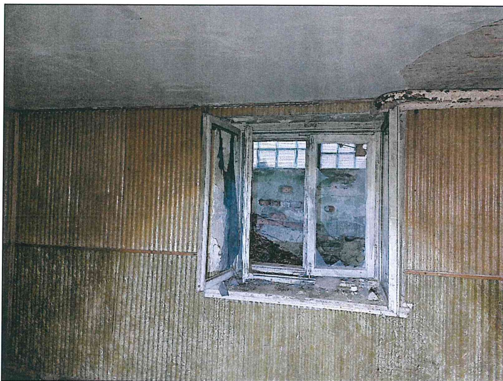
Фото 52. Подвал. Конструкции стен, перекрытий. Конструкции оконных проемов. Конструкции углового приямка фасадов № 1, № 2
