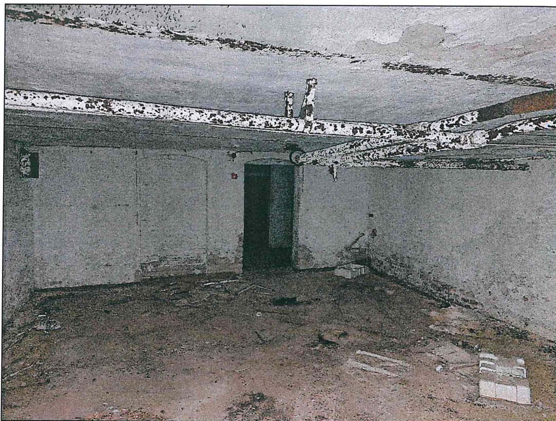
Фото 48. Подвал. Конструкции стен, перекрытий. Конструкции дверных проемов.
