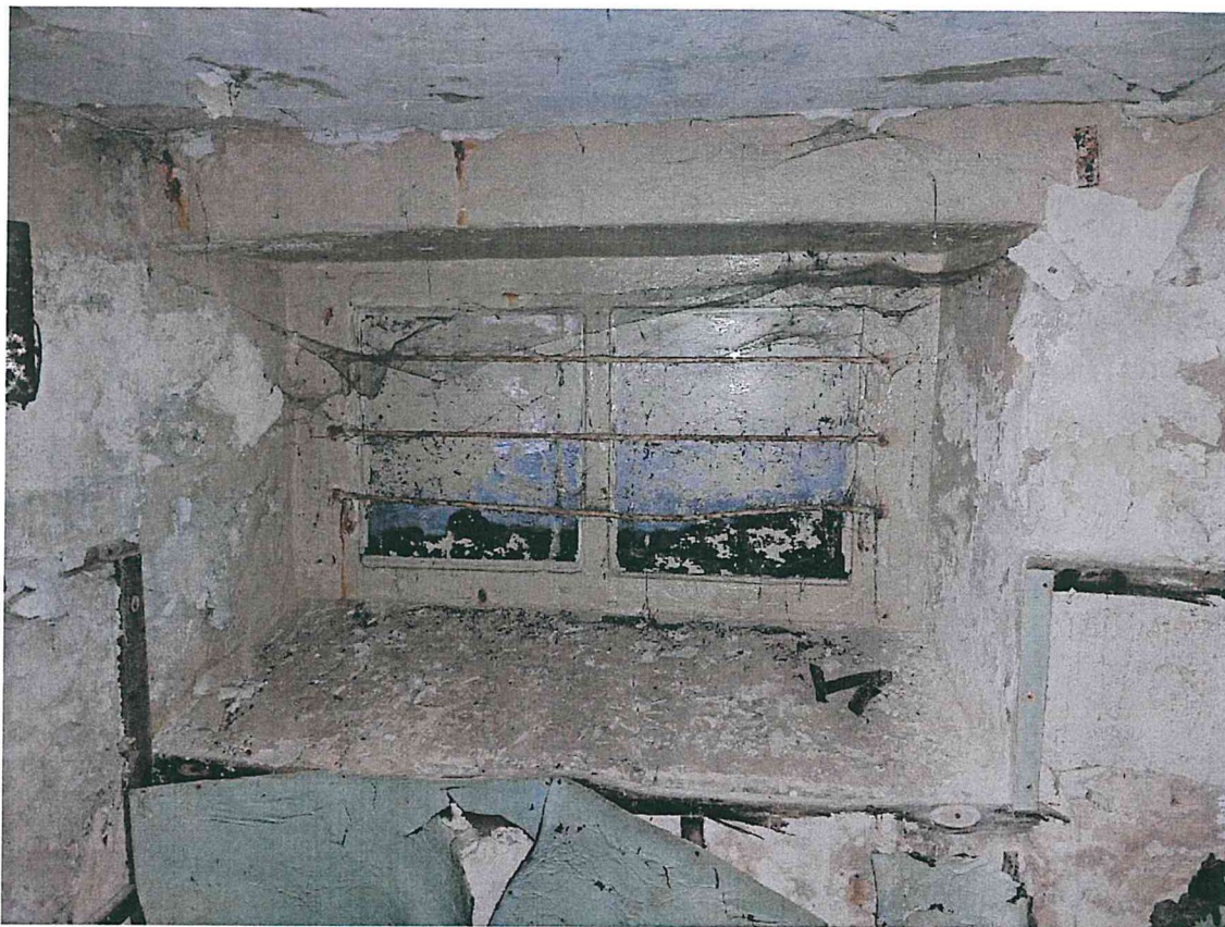
Фото 44. Подвал. Конструкции стен, перекрытий. Конструкции оконных проемов.
