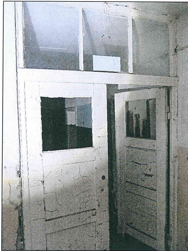
Фото 60. Первый этаж. Конструкции стен, перекрытий. Дверной проем входа во внутренние помещения первого этажа. Конструкция дверного заполнения.
