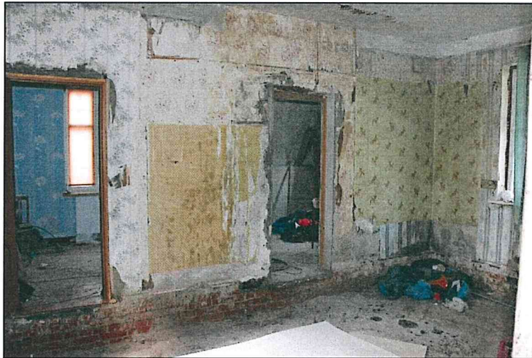
Фото 21. Первый этаж. Стены. Перекрытия. Оконные проемы. Дверные проемы (оригинальный, не оригинальный).
