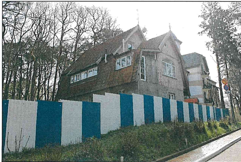
Фото 4. Общий вид. Западный фасад объекта, южный фасад объекта.
