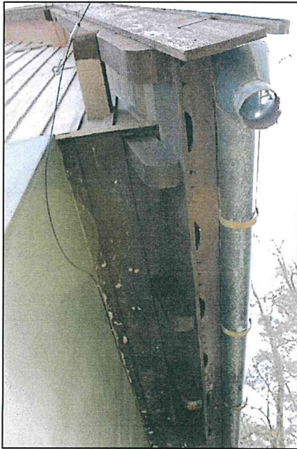
Фото 18. Южный фасад объекта. Стены. Карнизные свесы подшиты досками. Ветровая доска.
