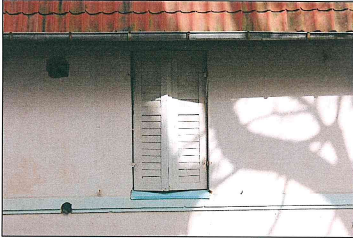
Фото 15. Южный фасад объекта. Стены, карнизы. Оконные проемы. Ставни. Навесы. Удерживающие декоративные металлические конструкции, вмонтированные в стены, в виде лошадиных головок, с поворотными механизмами.
