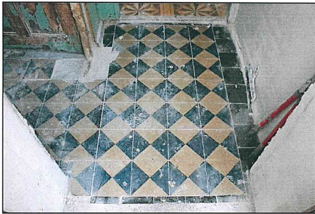
Фото 24. Первый этаж. Покрытие полов в коридоре первого этажа.
