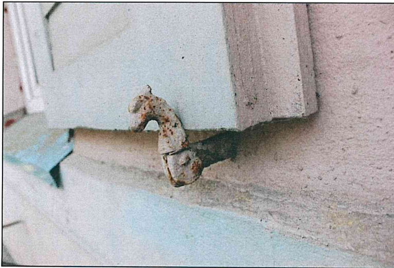
Фото 12. Северный фасад объекта. Стены, карнизы. Оконные проемы. Ставни. Удерживающие декоративные металлические конструкции, вмонтированные в стены, в виде лошадиных головок, с поворотными механизмами.
