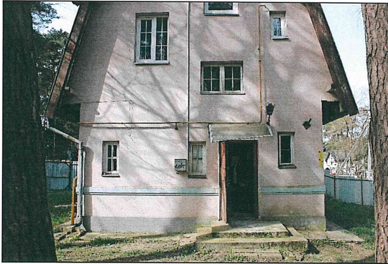
Фото 13. Восточный фасад объекта. Стены, карнизы. Оконные проемы.
