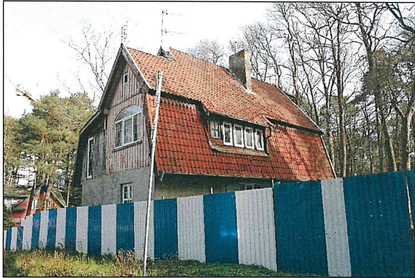
Фото 3. Общий вид. Южный фасад объекта, западный фасад объекта.
