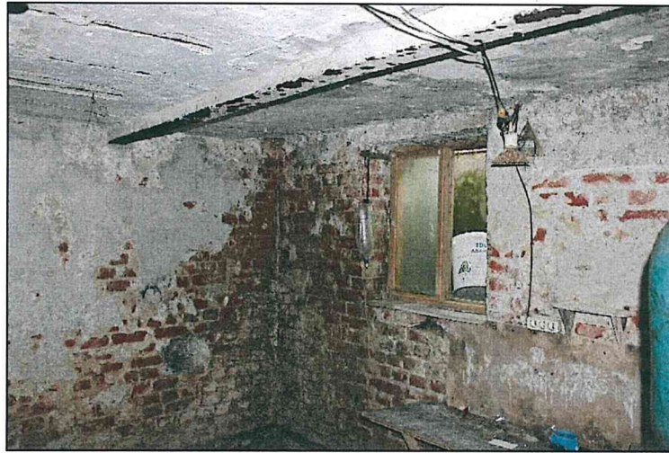
Фото 20. Подвал. Стены. Перекрытия. Оконные проемы.
