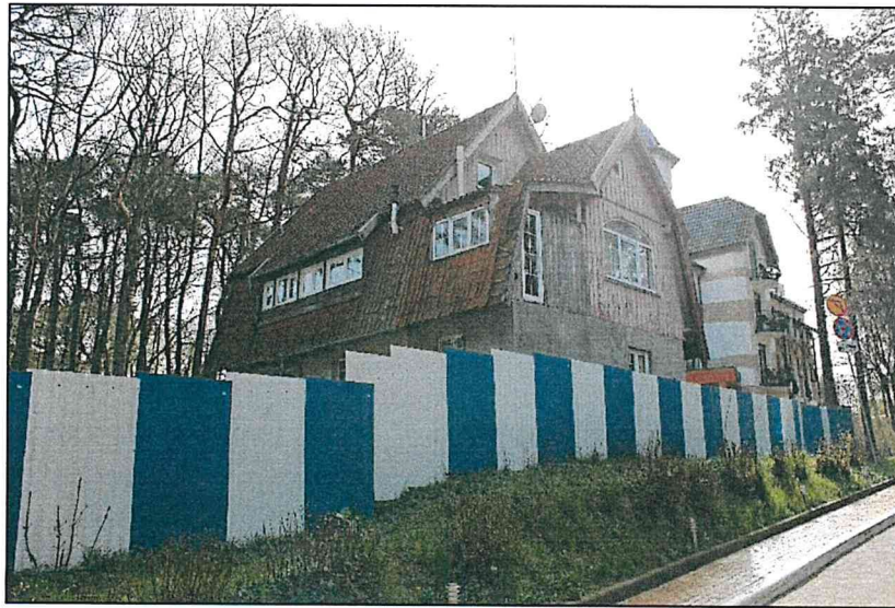
Фото 8. Общий вид. Западный фасад объекта, южный фасад объекта.
