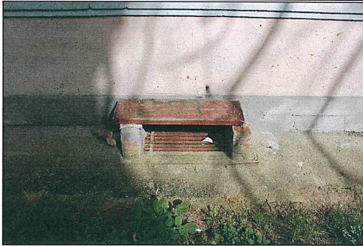
Фото 17. Южный фасад объекта. Стены, карнизы. Отмостка. Пряжки. Металлические решетки.
