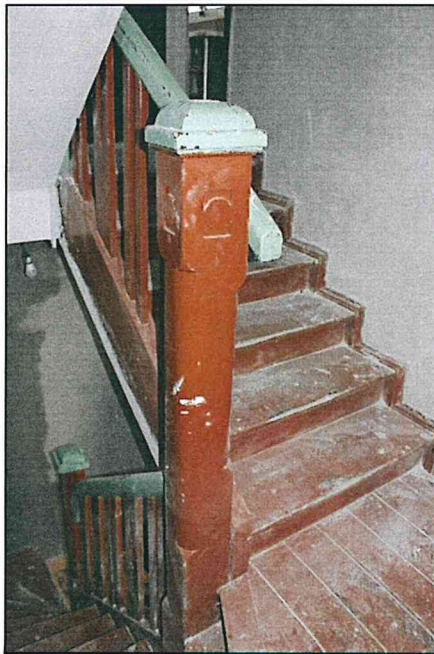
Фото 25. Первый этаж. Лестница между первым этажом и вторым этажом – мансардой.
