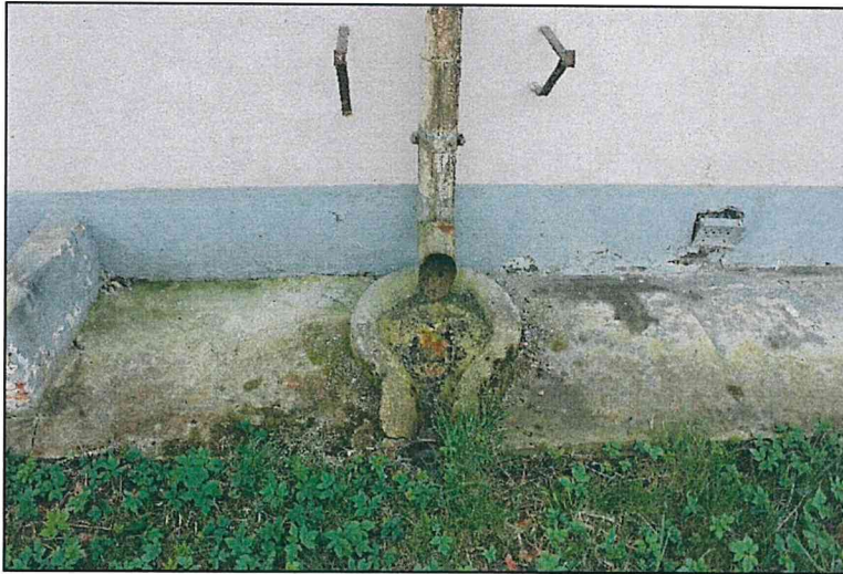
Фото 11. Северный фасад объекта. Отмостка. Приямки. Бетонные отметы водосточной системы. Кронштейны для цветочных ящиков.
