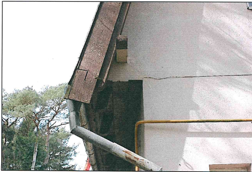
Фото 14. Восточный фасад объекта. Стены. Карнизные свесы подшиты досками. Ветровая доска.
