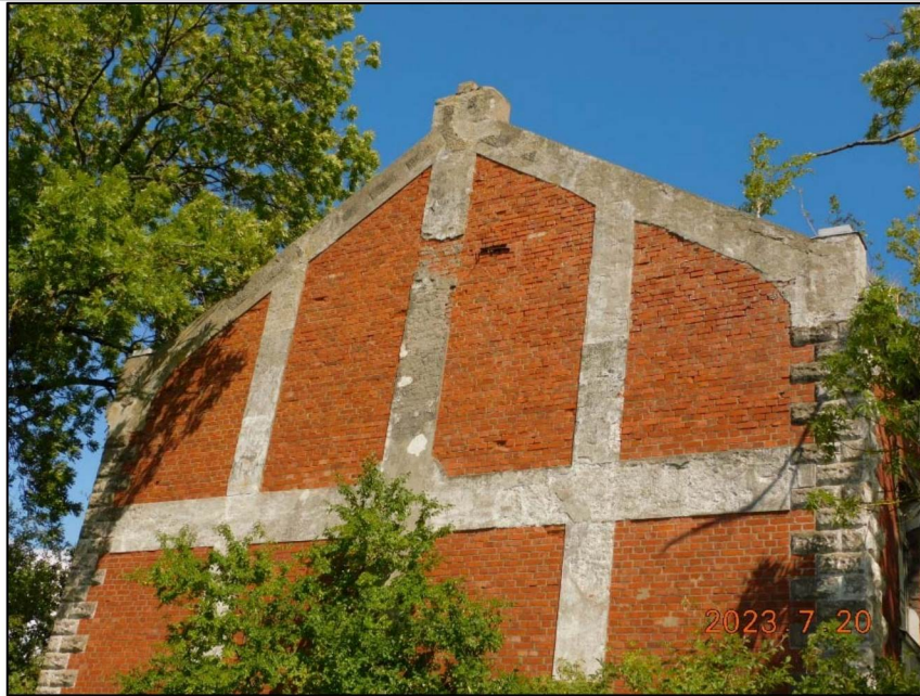
Фото 3. Лопатки и поясок на западном фасаде.
