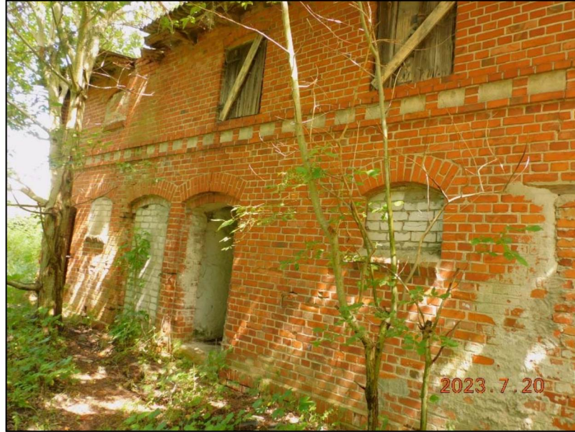
Фото 3. Фрагмент западного фасада.
