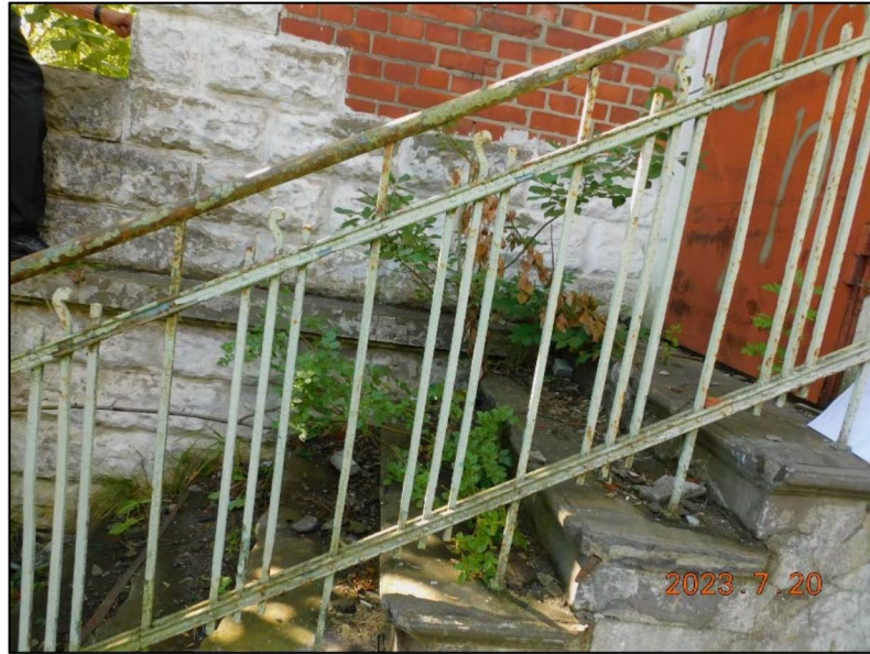
Фото 20. Вид кованого ограждения лестницы.
