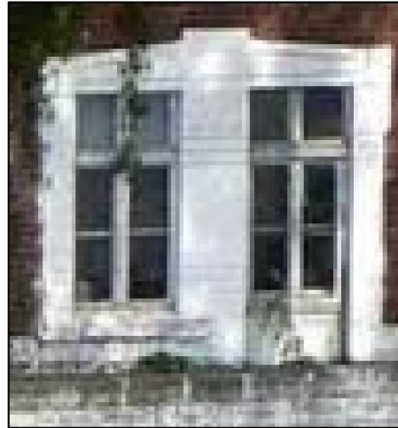
Фото 11. Оконный проем и дверной проем выхода на террасу.
