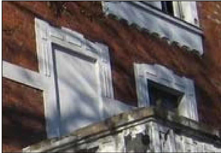
Фото 17. Декоративное оформление оконного проема и дверного проема выхода на балкон в уровне второго этажа на восточном фасаде.
