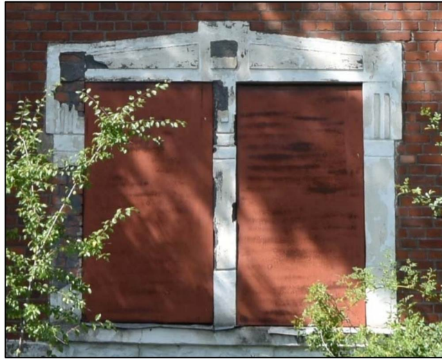
Фото 10. Декоративное оформление двойных оконных проемов первого этажа на южном фасаде.
