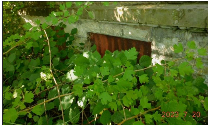
Фото 12. Оконные проемы подвала.
