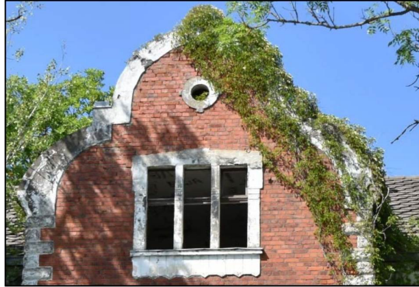
Фото 7. Фронтон центрального ризалита южного фасада.
