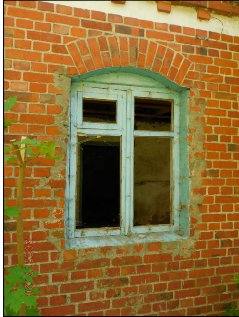
Фото 7. Оконные проемы на северном фасаде.
