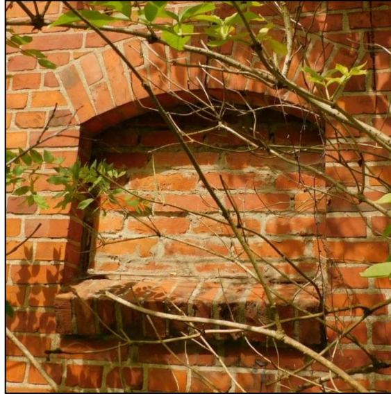
Фото 7. Вид оконных проемов на южном фасаде.
