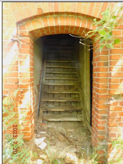
Фото 10. Дверной проем на западном фасаде.
