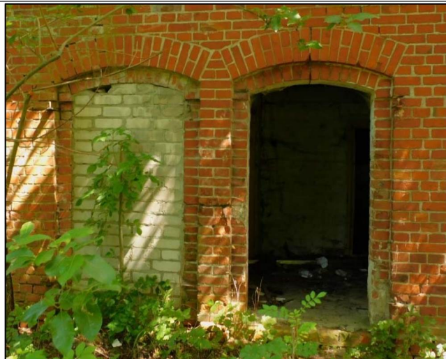
Фото 9. Двойной дверной проем на западном фасаде.
