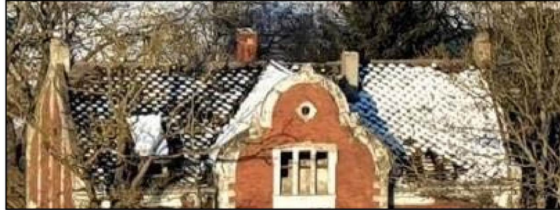
Фото 4. Вид южного ската крыши.
