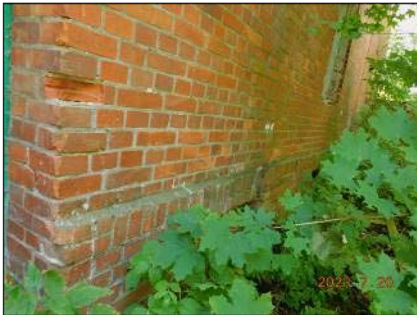
Фото 2. Вид кладки стены и цоколя северного фасада.
