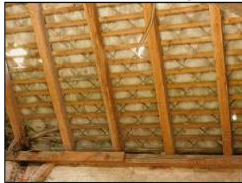
Фото 5. Вид кровельного покрытия крыши с внутренней стороны.
