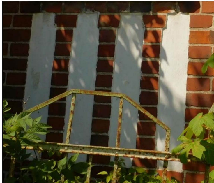
Фото 4. Декоративные ниши в подоконных парапетах оконных проемов.
