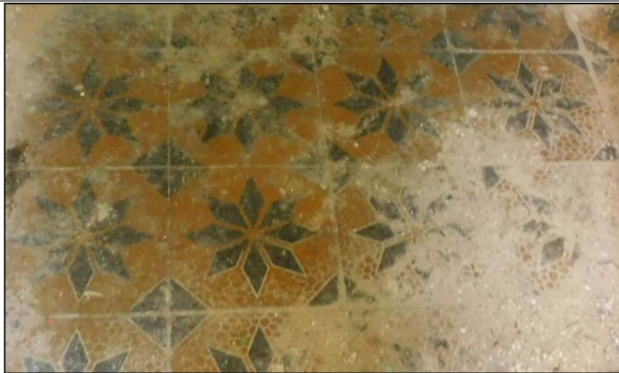
Фото 1. Вид напольного покрытия.
