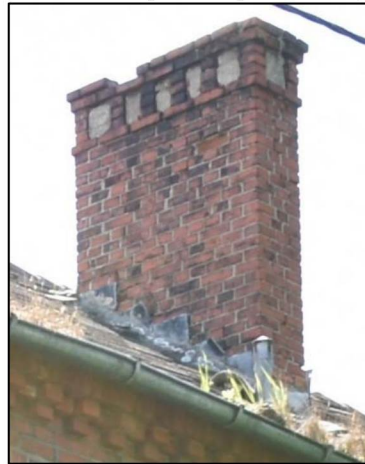
Фото 6. Вид дымовой трубы на северном скате крыши.
