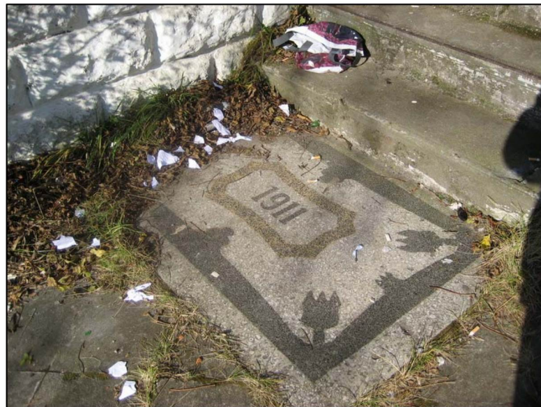
Фото 21. Плита перед лестничным маршем на южном фасаде.
