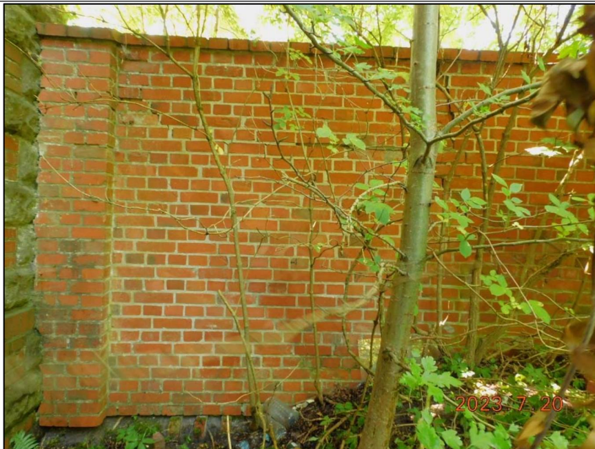
Фото 5. Фрагмент ограждения с западной стороны.
