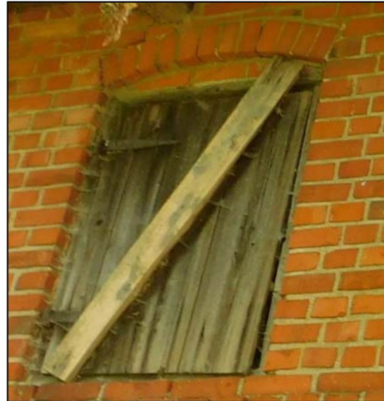
Фото 8. Вид оконных проемов чердака на западном фасаде.
