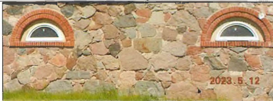
Фото 3. Вид кладки стены и цоколя южного главного фасада.
