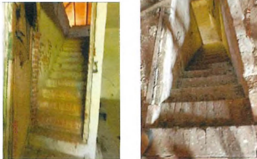
Фото 4, 4а. Межэтажная лестница.
