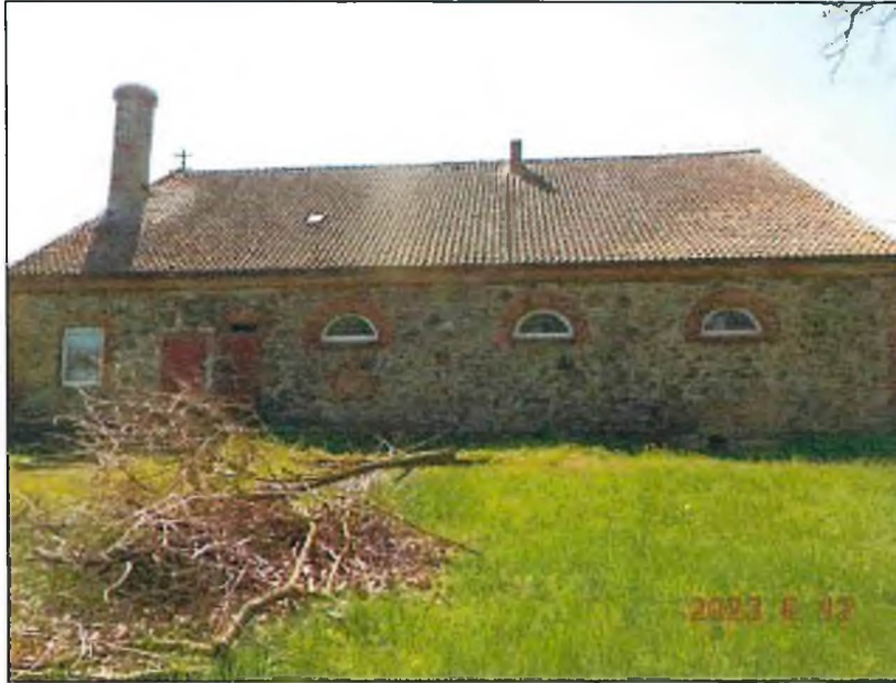
Фото 4. Северный дворовый фасад Памятника.
