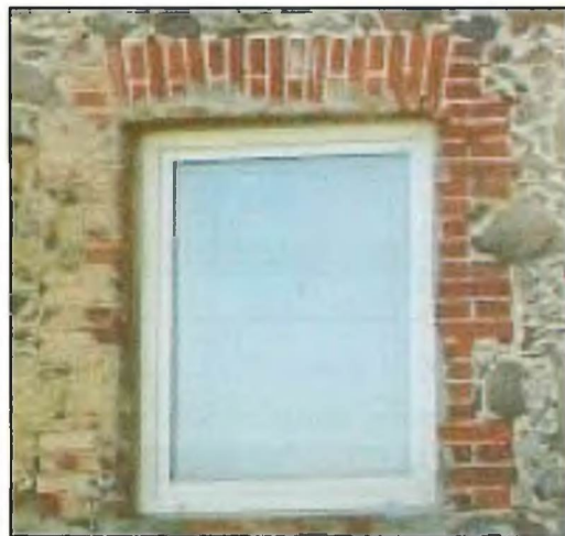
Фото 10. Вид оконного проема на северном фасаде.
