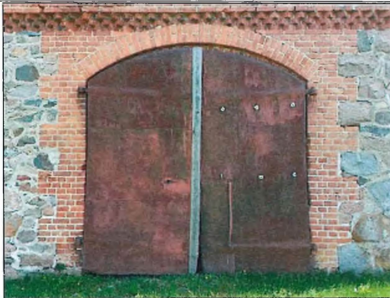
Фото 15. Проездной проем на западном фасаде.
