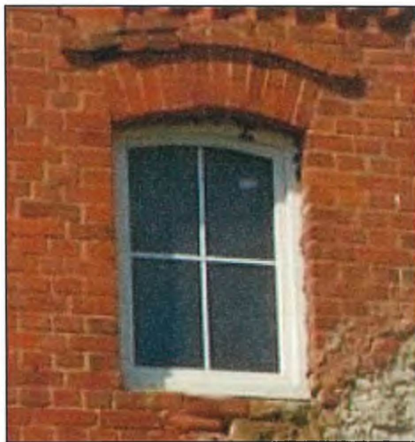
Фото 9. Вид оконного проема с лучковой перемычкой.
