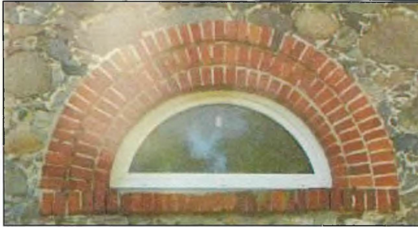
Фото 2. Декоративное оформление оконных проемов с арочными перемычками на северном фасаде.
