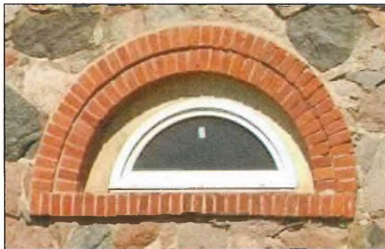
Фото 1. Декоративное оформление оконных проемов с арочными перемычками на южном фасаде.
