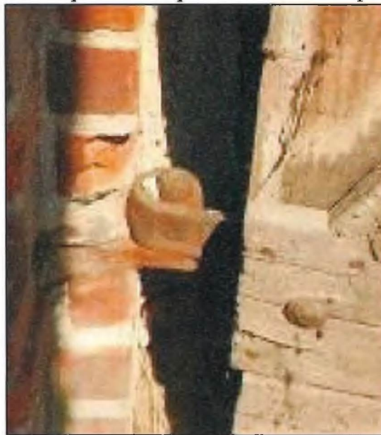
Фото 16. Дверные петли проездных проемов.
