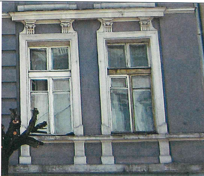
Фото 6. Оконные проемы северного главного фасада Памятника.
