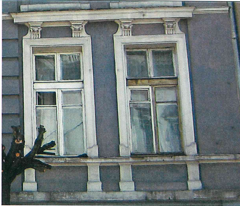
Фото 3. Декоративное оформление оконных проемов в уровне второго этажа.
