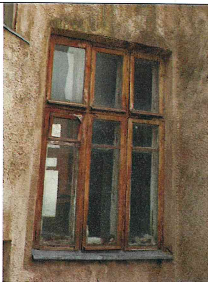
Фото 8. Оконные проемы южного дворового фасада и западного дворового фасада Памятника.
