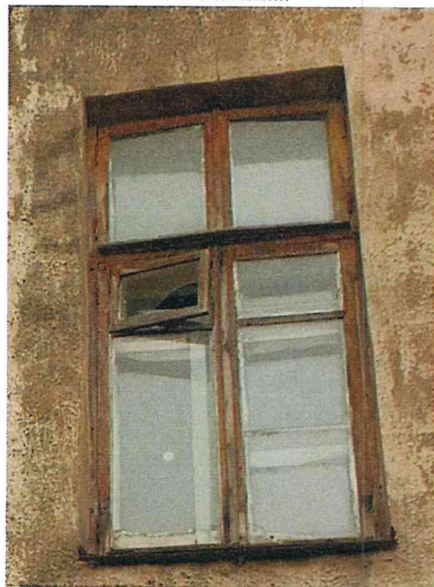
Фото 9. Оконные проемы южного дворового фасада, восточного и западного дворовых фасадов Памятника.
