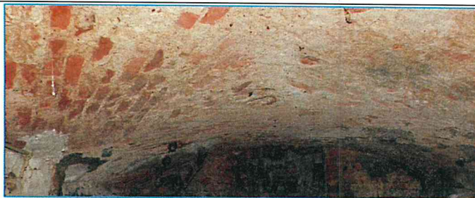
Фото 4. Перекрытие подвала: кирпичные своды лучкового очертания.
