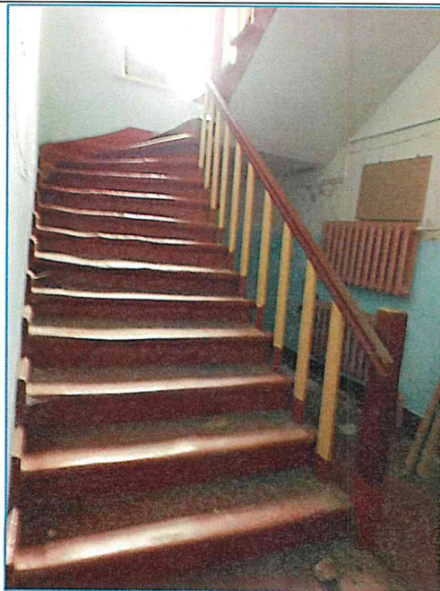
Фото 2. Главная лестница. Вид с площадки первого этажа.
