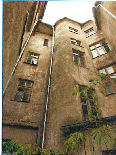
Фото 7. Фрагмент южного дворового фасада основного объема.
