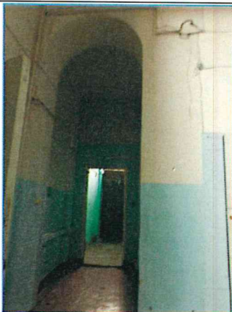
Фото 1. Арочный проем на площадке первого этажа.
