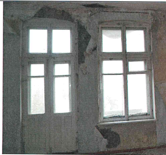
Фото 11. Балконные оконные и дверные проемы северного главного фасада Памятника с внутренней стороны.
