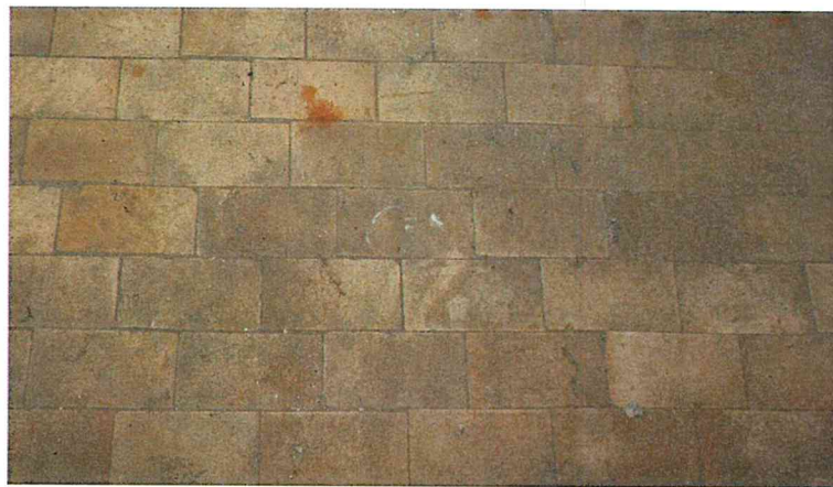
Фото 4. Напольное покрытие в помещении подвала.
