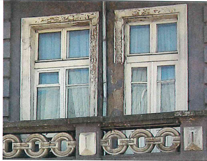
Фото 10. Балконные оконные и дверные проемы северного главного фасада Памятника.
