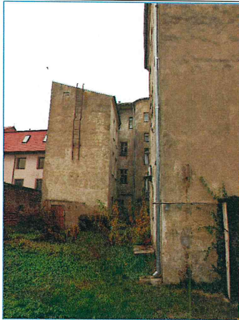
Фото 6. Южный дворовый фасад Памятника.
