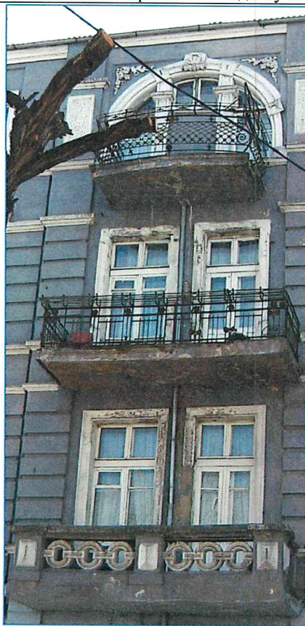
Фото 5. Общий вид балконов
