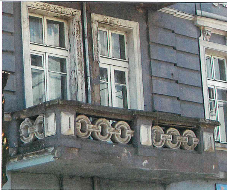
Фото 8. Декоративное оформление балкона в уровне второго этажа.
