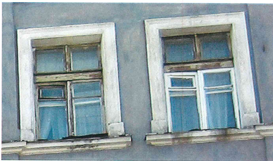
Фото 5. Декоративное оформление оконных проемов в уровне четвертого этажа.
