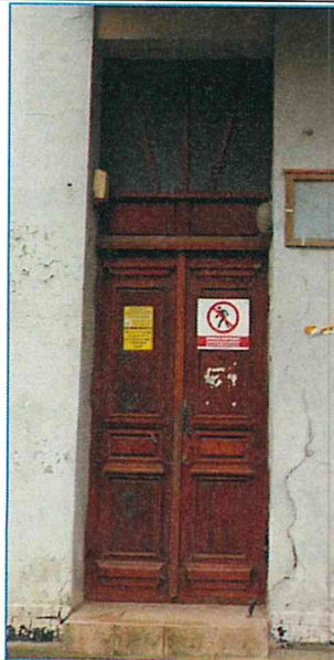
Фото 13. Дверной проем главного входа на северном главном фасаде.
