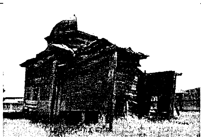
Фото 4. Здание церкви со стороны северо-запада.
