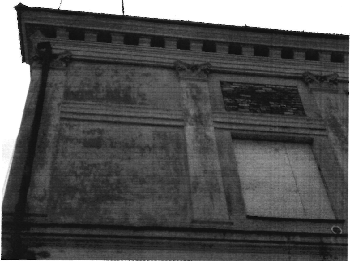
Фото 5 – Фрагмент северо-восточного фасада
