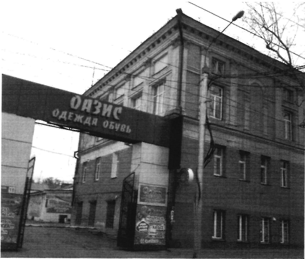
Фото 3 – Фрагмент главного фасада по улице Тимирязева и северо-восточного фасада
