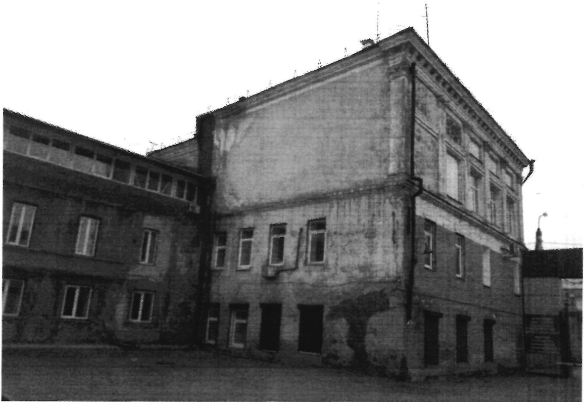
Фото 4 – Фрагмент северо-восточного фасада
