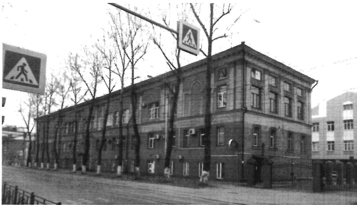
Фото 1 – Фрагмент главного юго-восточного фасада
