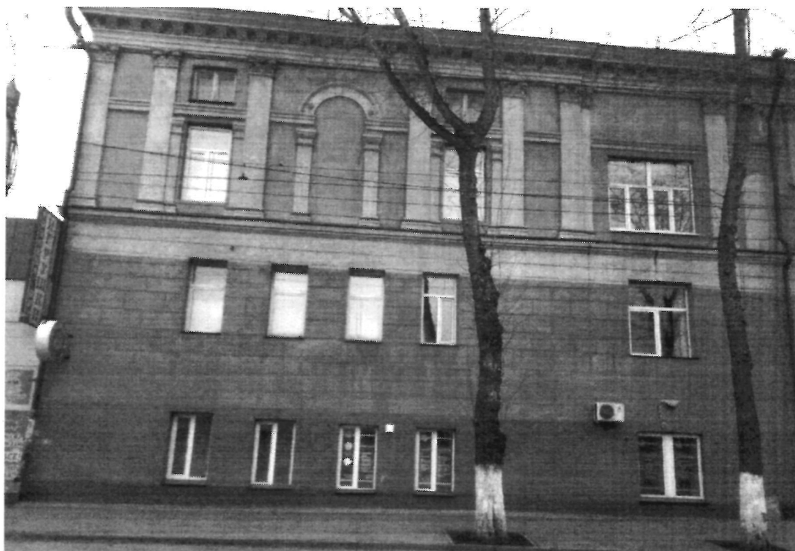
Фото 2 – Фрагмент главного юго-восточного фасада
