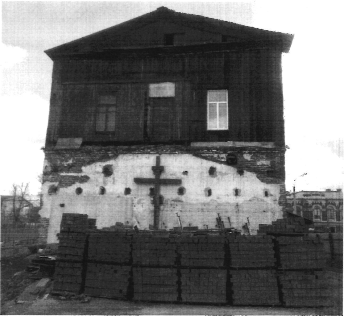
Фото 3 – Торцевой (западный) фасад
