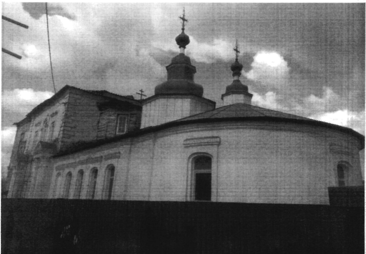
Фото 2 – Фрагмент главного фасада
