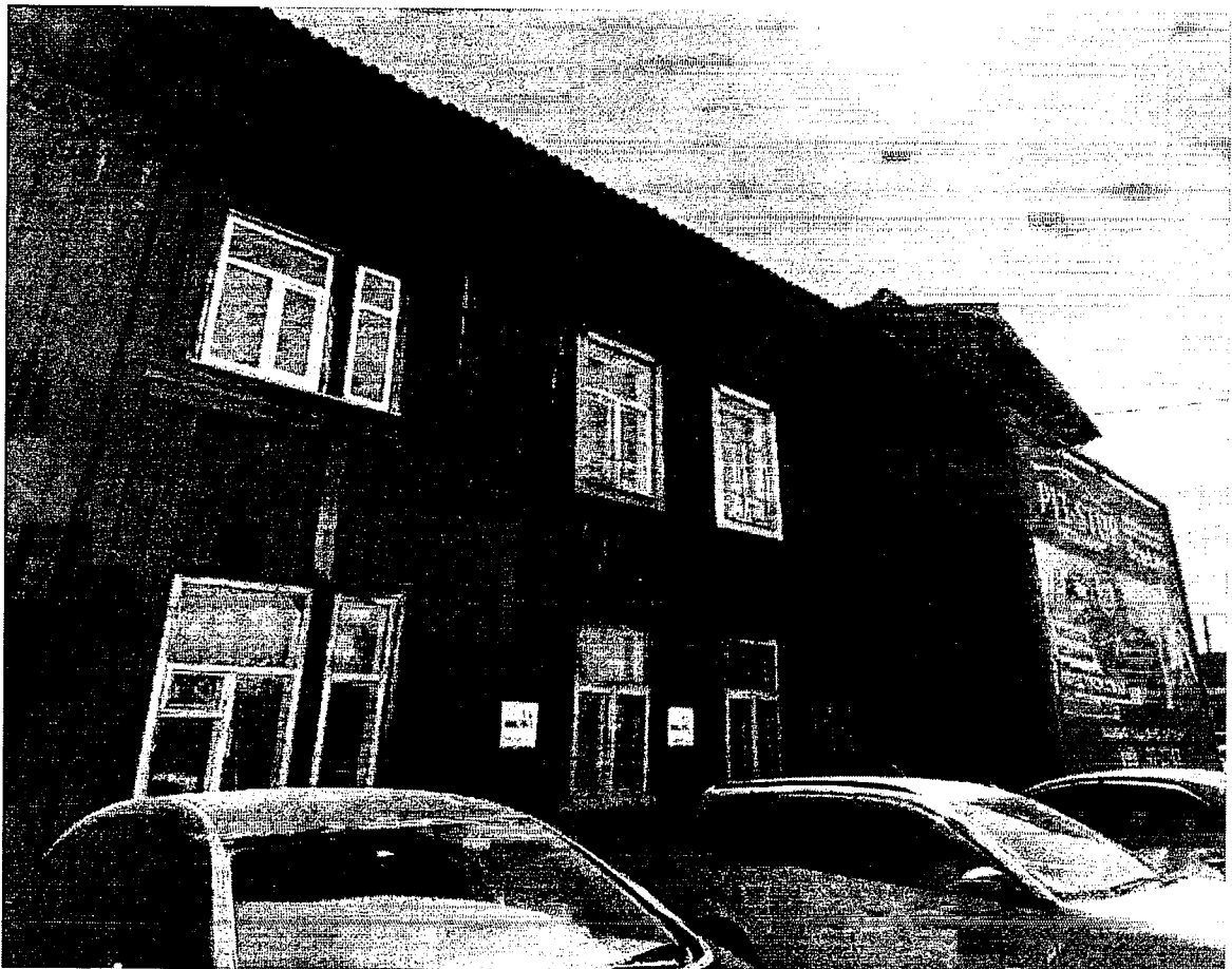
Фото 4 – Фрагмент бокового фасада
