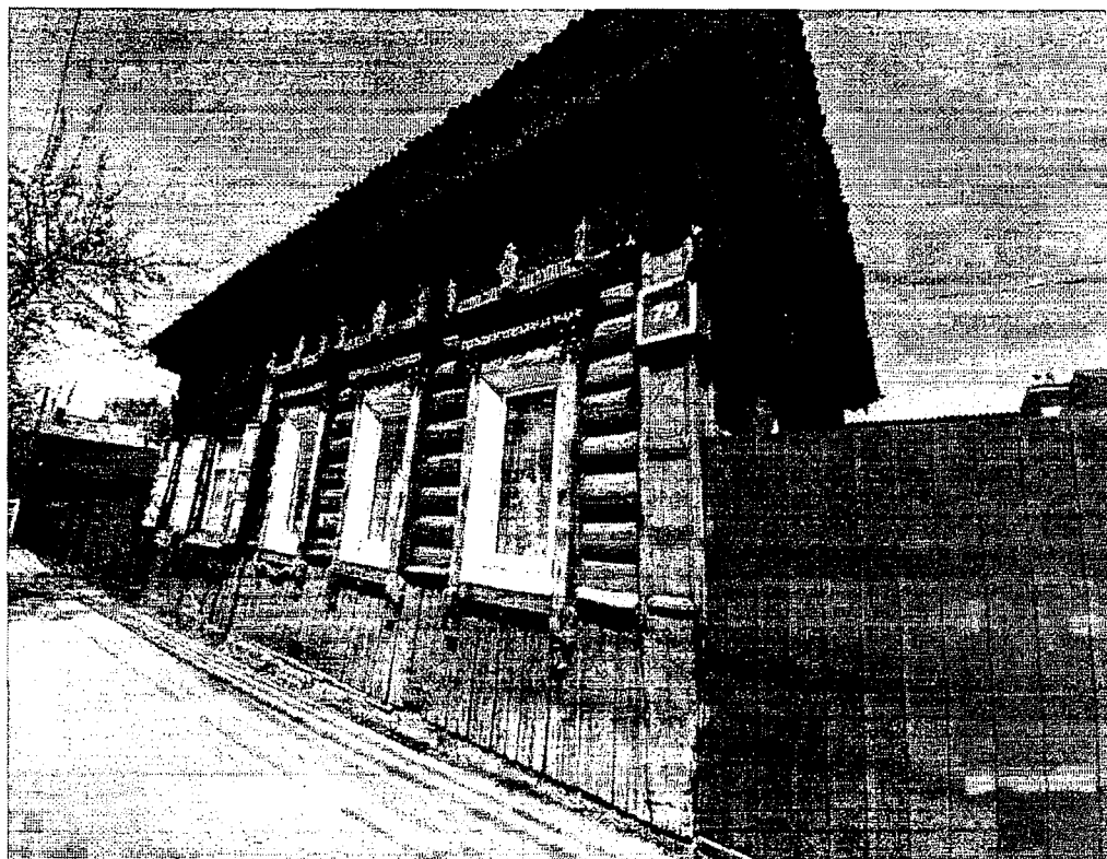
Фото 1 – Юго-западный угол «Доходного дома»
