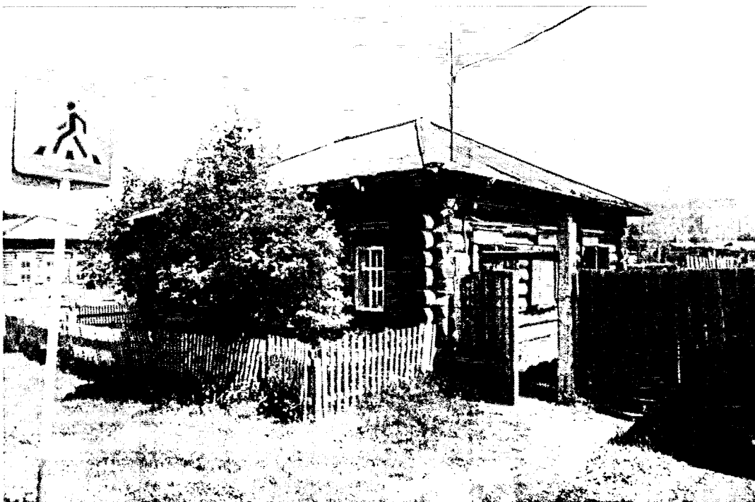
Фото 2 – Торцевой (правый) фасад
