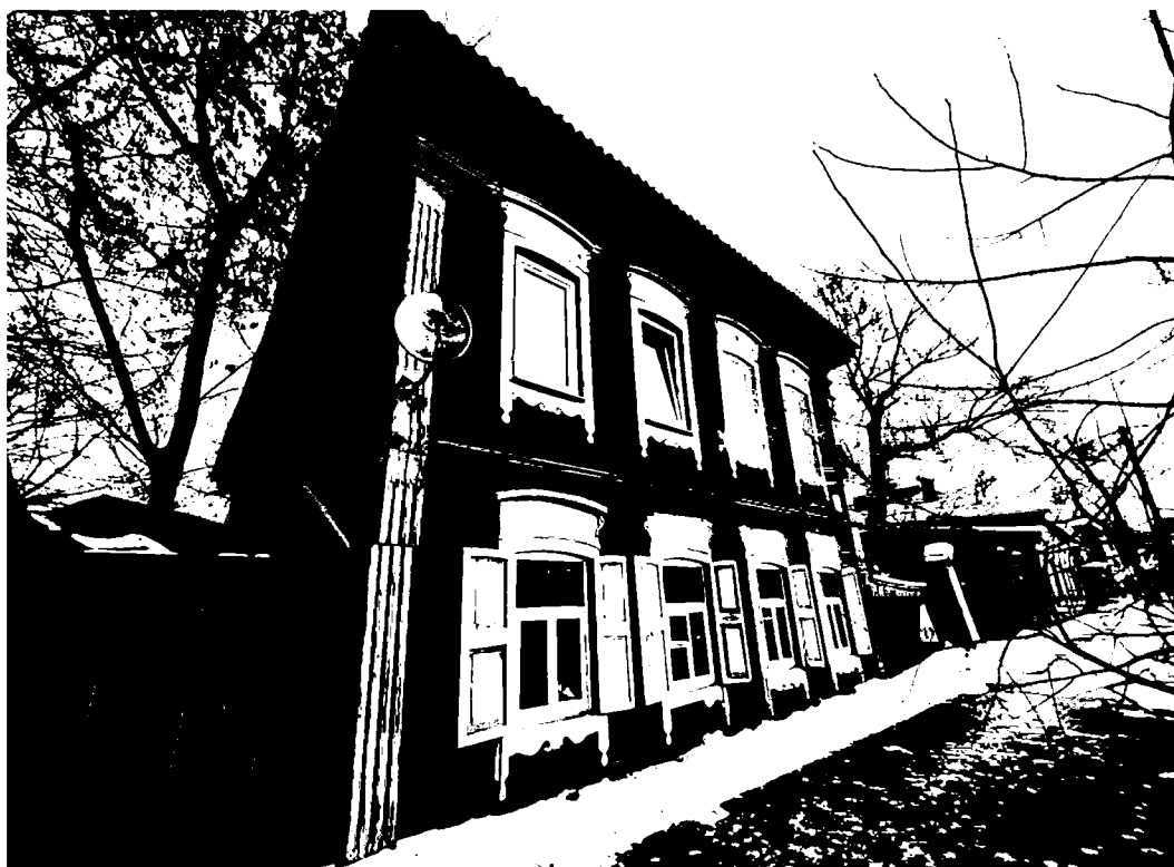
Фото 2. Вид на «Жилой дом» со стороны улицы Желябова, с запада. Фрагменты северо-западного и юго-западного фасадов
