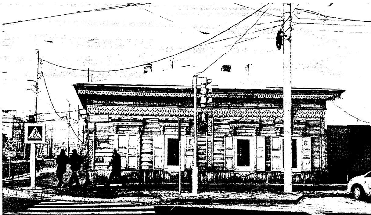
Фото 2 – Боковой (юго-восточный) фасад
