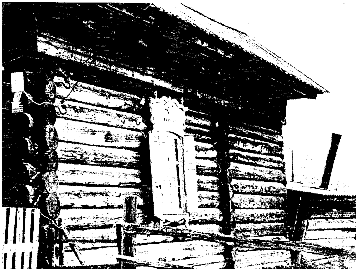
Фотография № 4. Фрагмент северо-восточного фасада объекта культурного наследия
