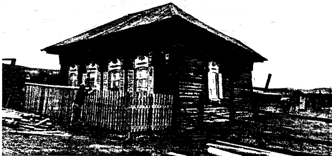
Фотография № 1. Вид с улицы Лесная на юго-восточный и северо-восточный фасад объекта культурного наследия
