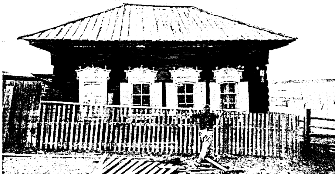
Фотография № 2. Вид с улицы Лесная на юго-восточный фасад объекта культурного наследия
