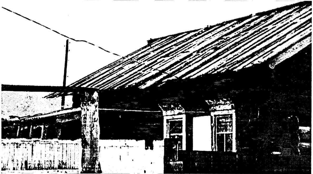
Фотография № 4. Фрагмент юго-западного фасада объекта культурного наследия
