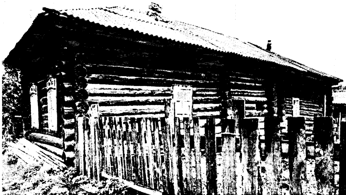
Фотография № 1. Вид с ул. Центральная на юго-восточный и северо-восточный фасады объекта культурного наследия
