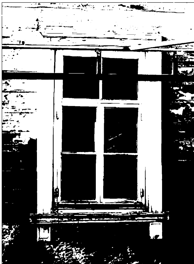
Фото 32. Наличник оконного проема первого этажа, северо-восточный фасад.
