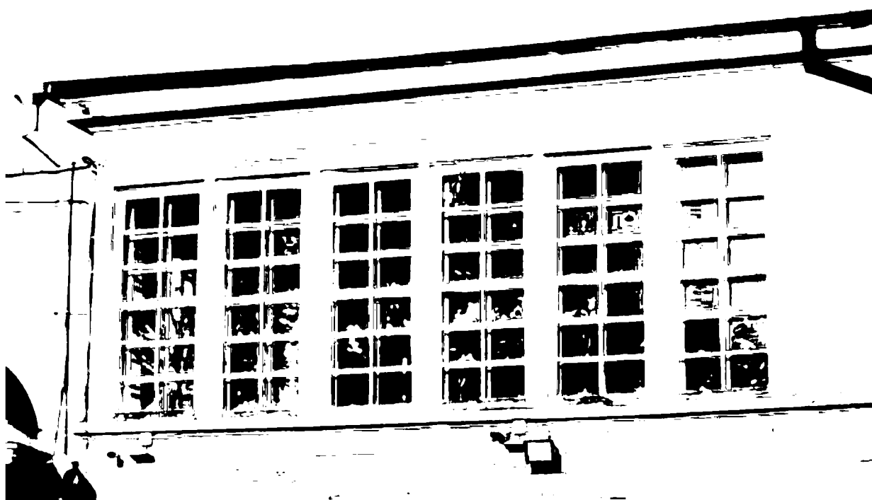
Фото 25. Ленточное остекление веранды-светелки, юго-восточный фасад.
