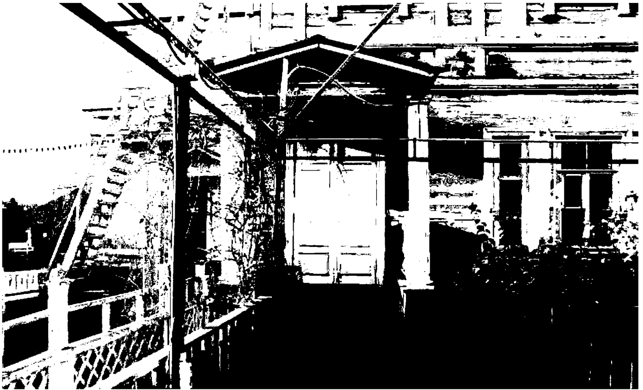
Фото 30. Крыльцо северо-восточного фасада.
