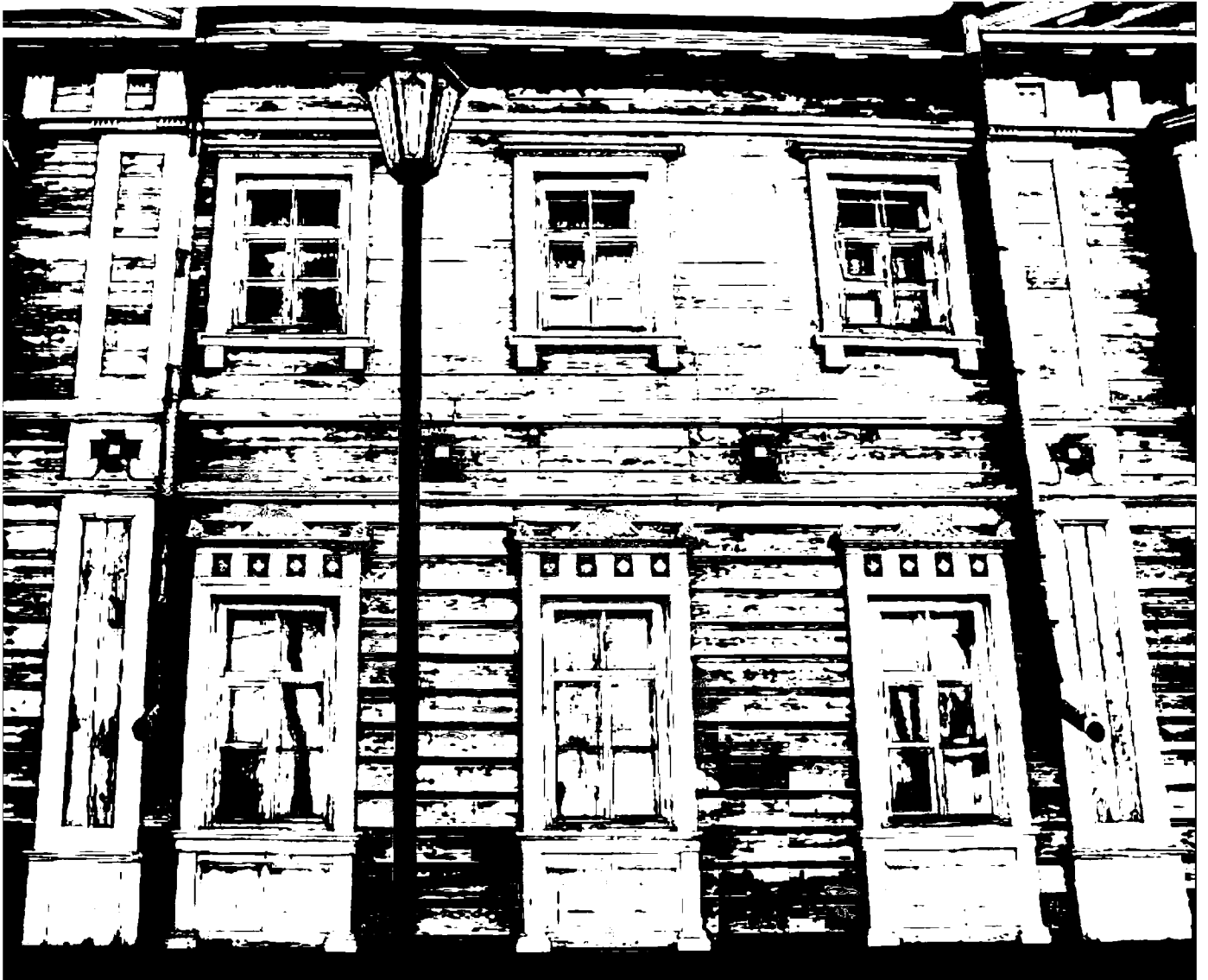
Фото 4. Фрагмент северо-западного фасада.
