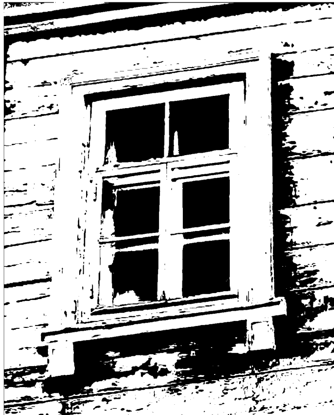
Фото 35. Наличник оконного проема второго этажа, северо-восточный фасад.
