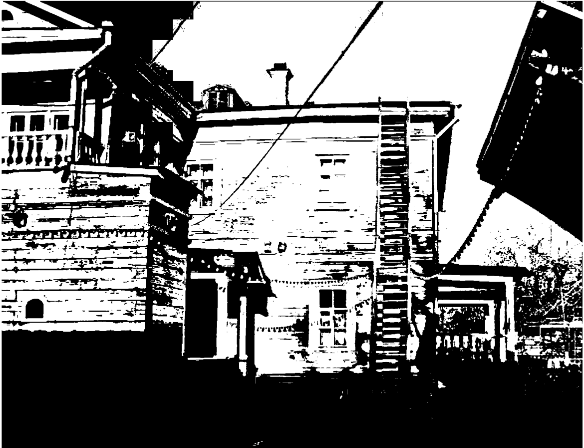
Фото 21. Фрагмент юго-восточного фасада.
