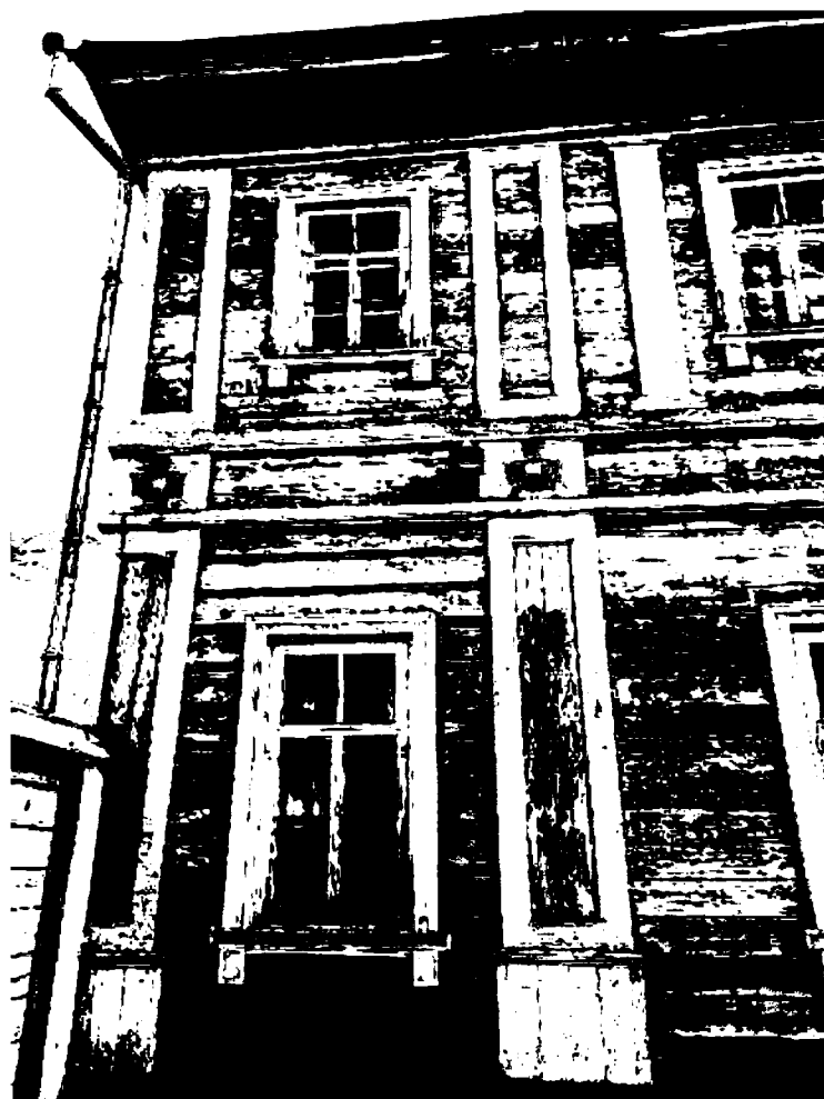
Фото 11. Фрагмент юго-западного фасада.
