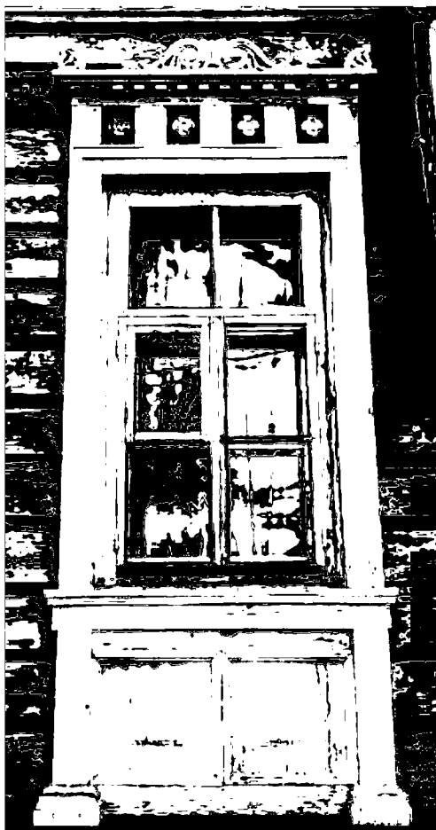
Фото 7. Наличник оконного проема первого этажа, северо-западный фасад.
