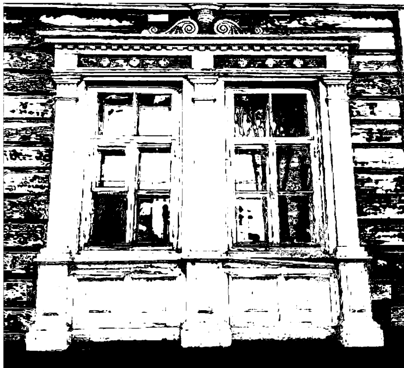
Фото 6. Наличник спаренного оконного проема первого этажа, северо-западный фасад.
