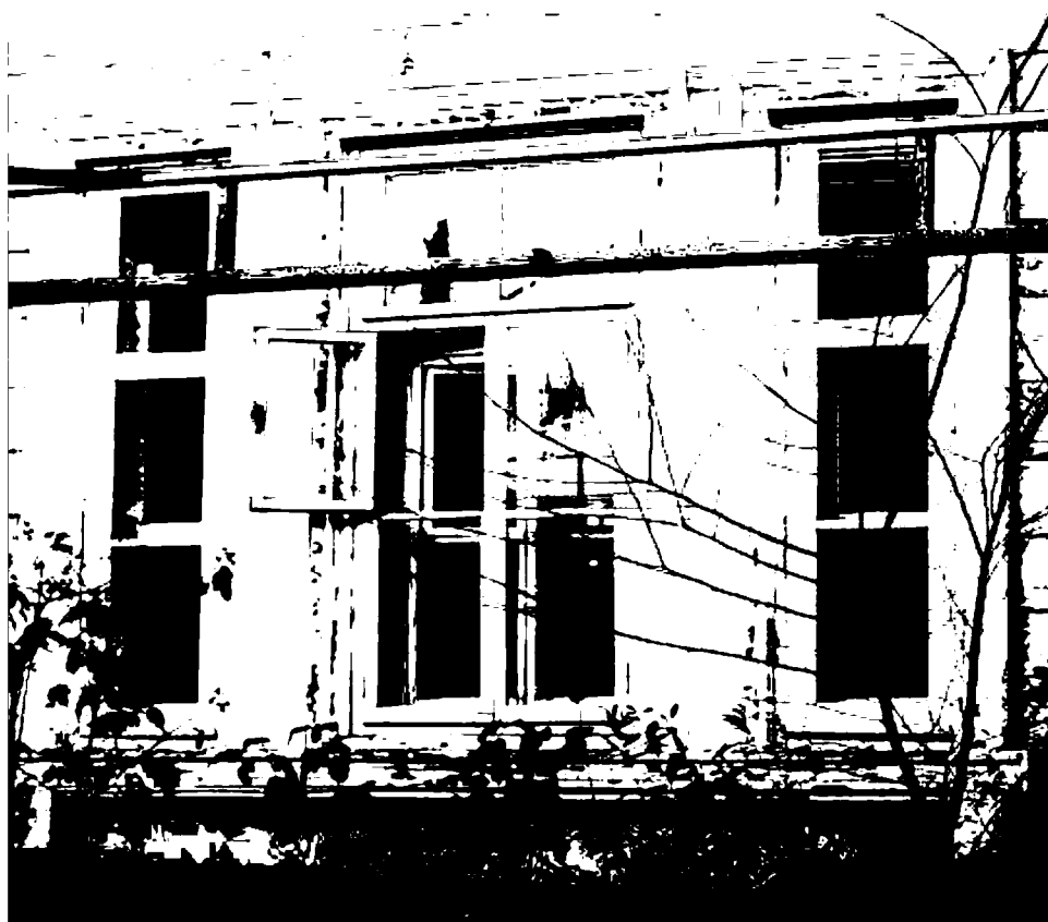
Фото 33. Наличник трехчастного оконного проема первого этажа, северо-восточный фасад.
