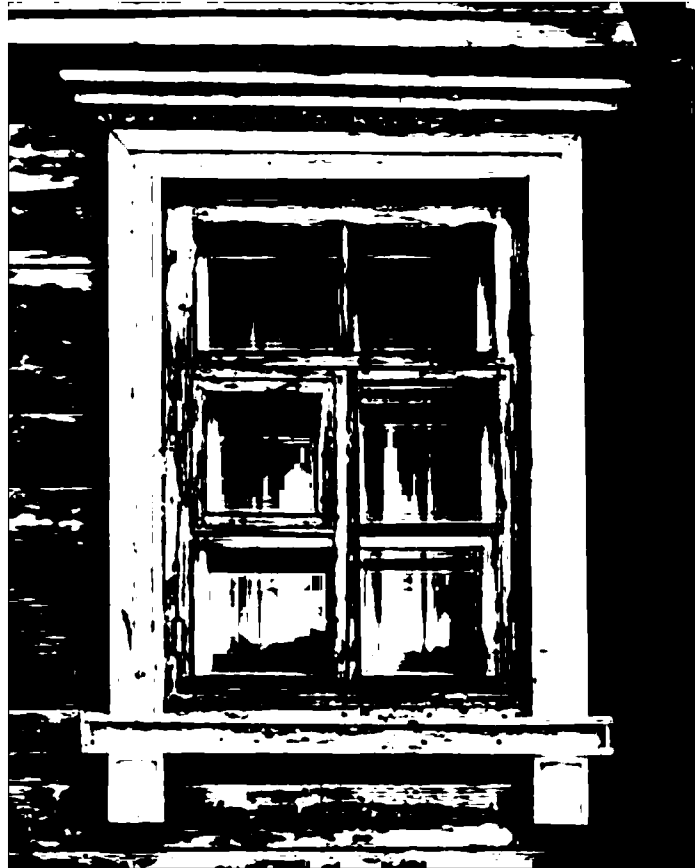
Фото 8. Наличник оконного проема второго этажа, северо-западный фасад.
