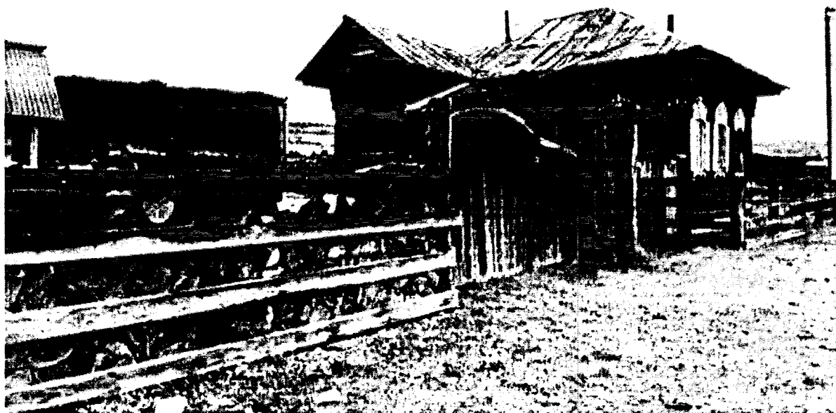
Фотография № 1. Вид с улицы Центральная на въездную группу и юго-западный, юго-восточный фасады объекта культурного наследия
