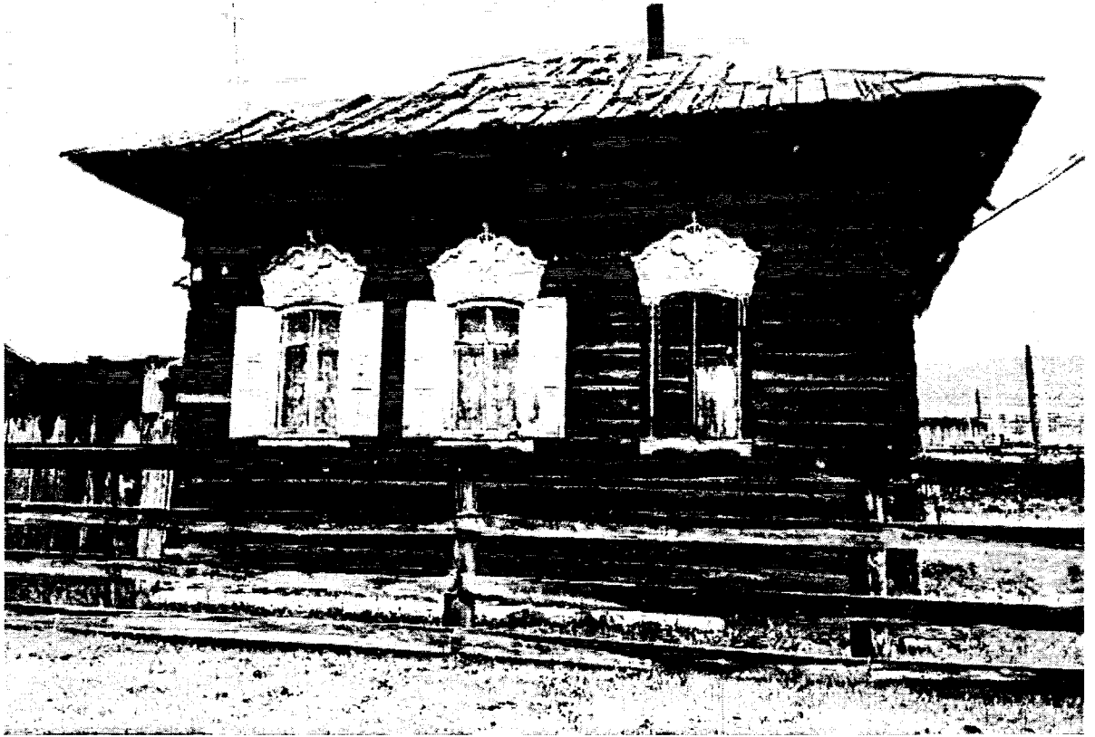
Фотография № 3. Вид на юго-восточный фасад объекта культурного наследия
