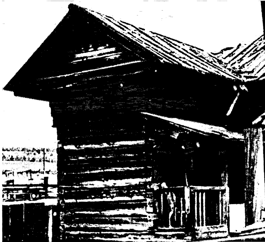
Фотография № 4. Фрагмент юго-западного фасада объекта культурного наследия
