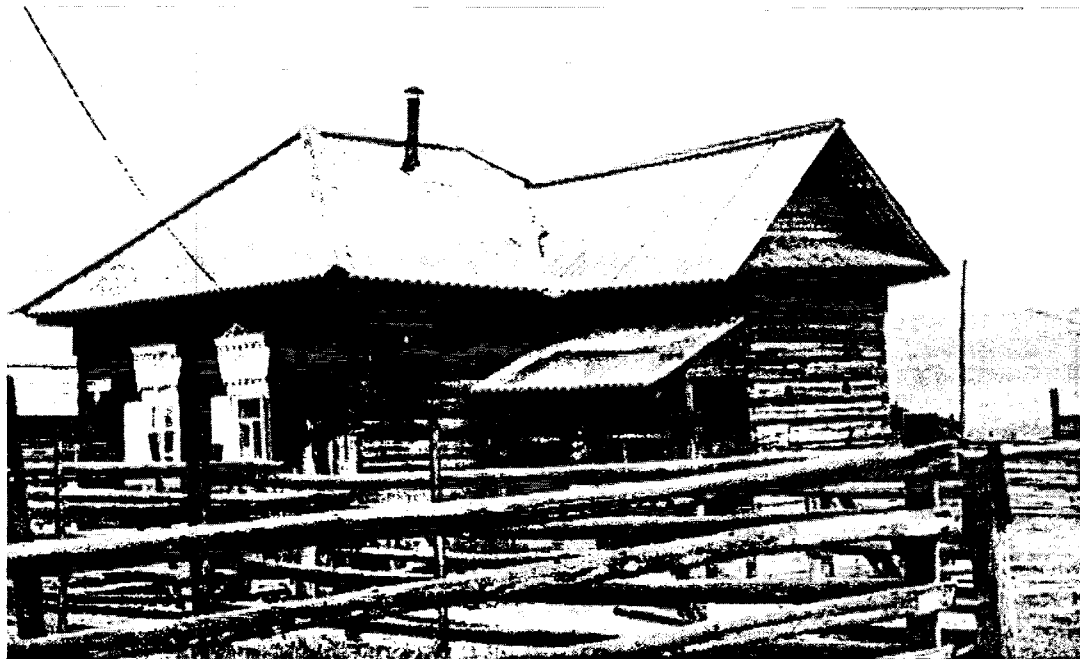
Фотография № 1. Вид на северный и восточный фасады объекта культурного наследия
