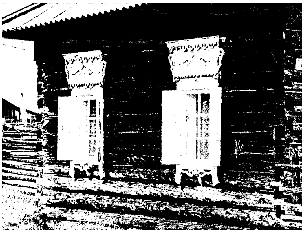
Фотография № 4. Фрагмент восточного фасада объекта культурного наследия
