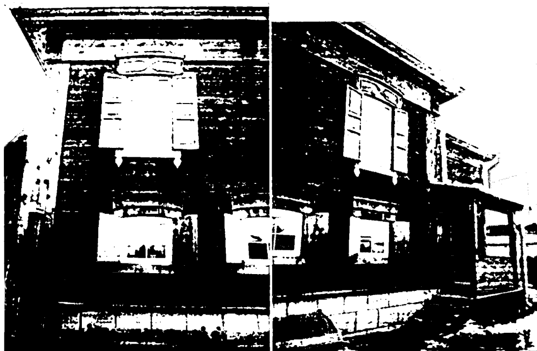
4. Дворовой северо-восточный фасад (фрагменты левого и правого флангов)
