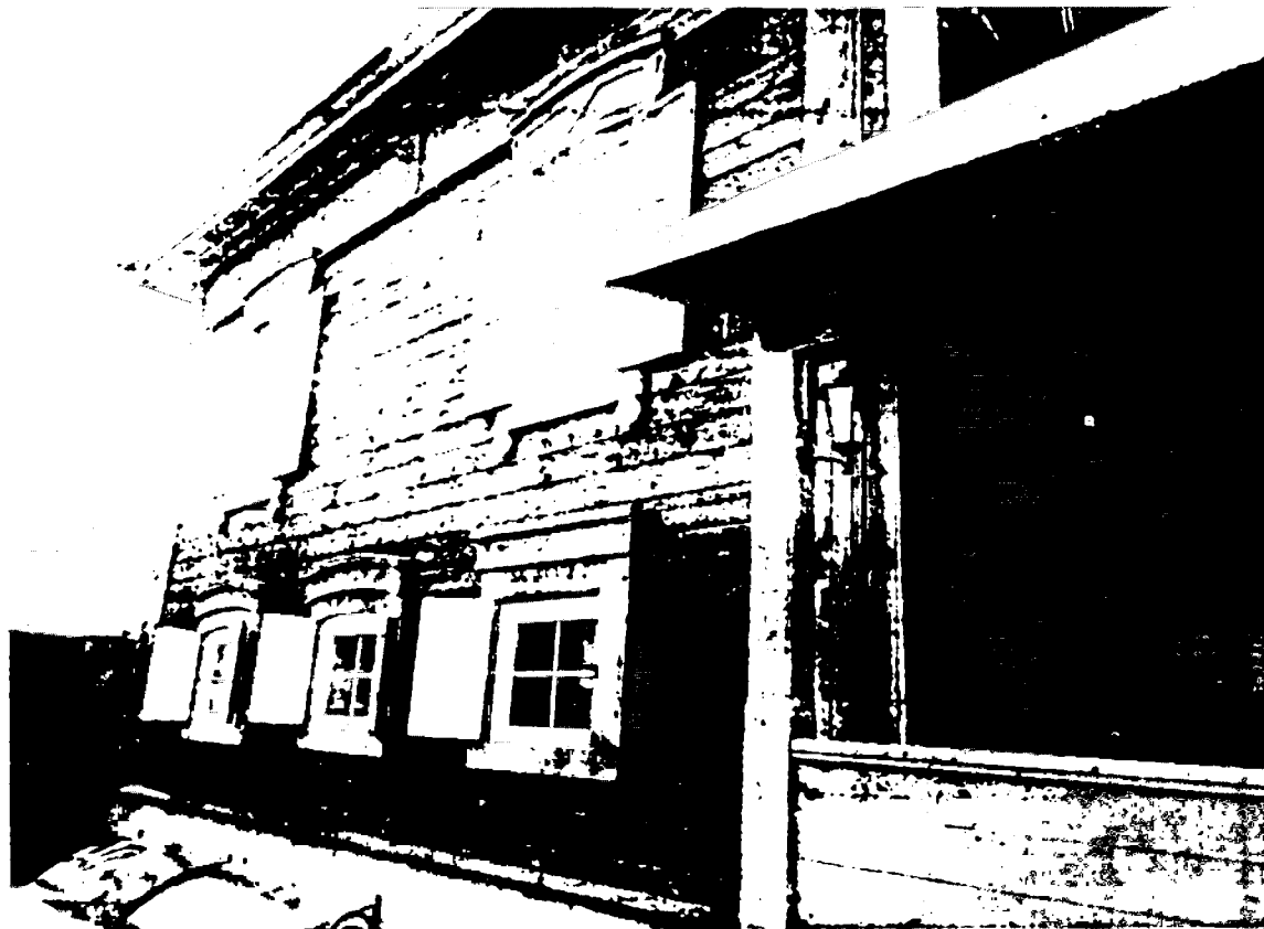
3. Дворовой северо-восточный фасад (фрагмент левого фланга)
