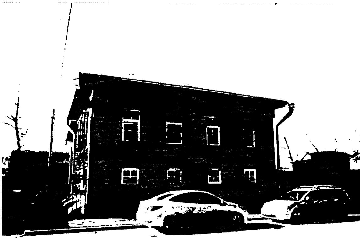
1. Общий вид здания с ул. Желябова
