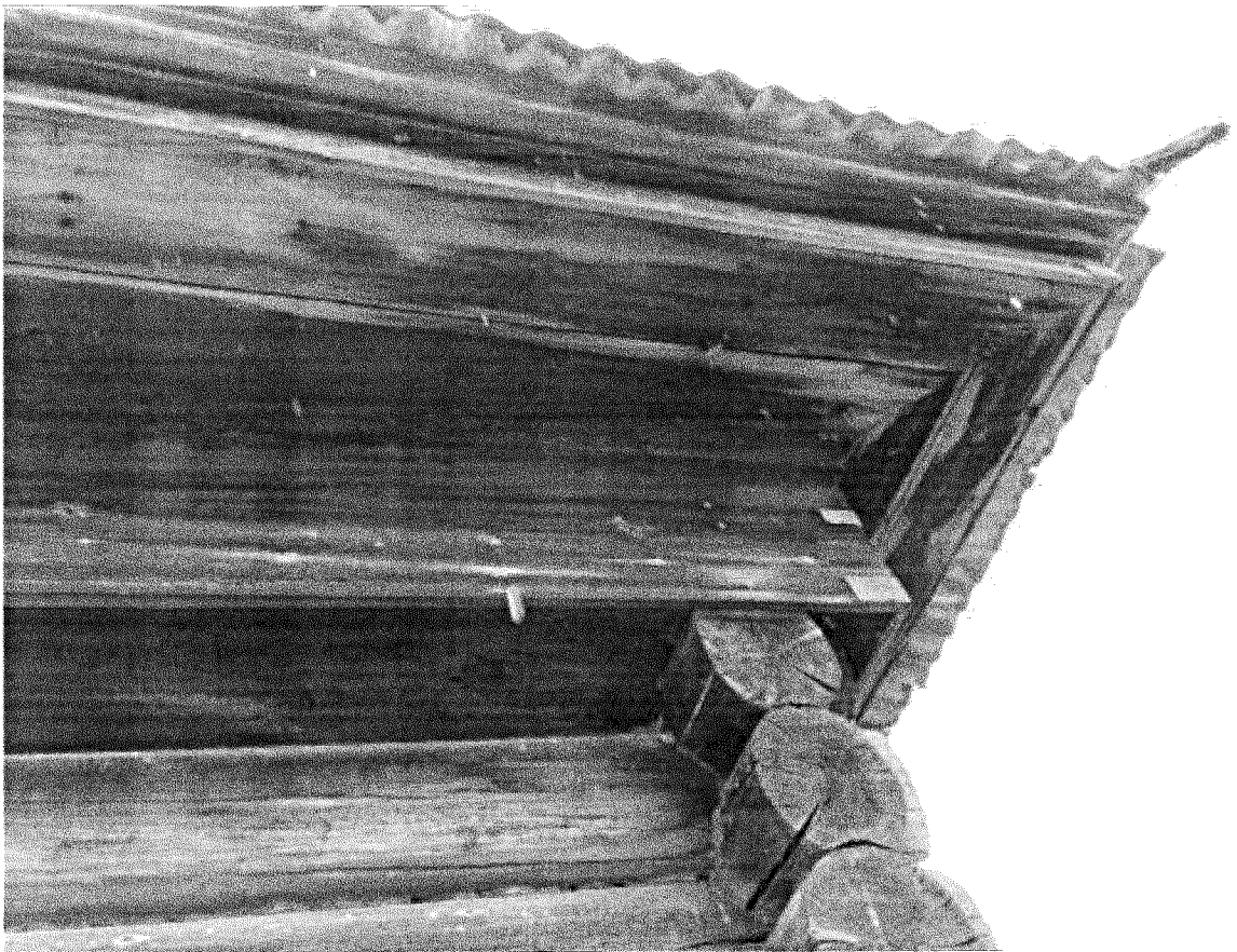
Фотография №4. Фрагмент северо-восточного фасада объекта культурного наследия
