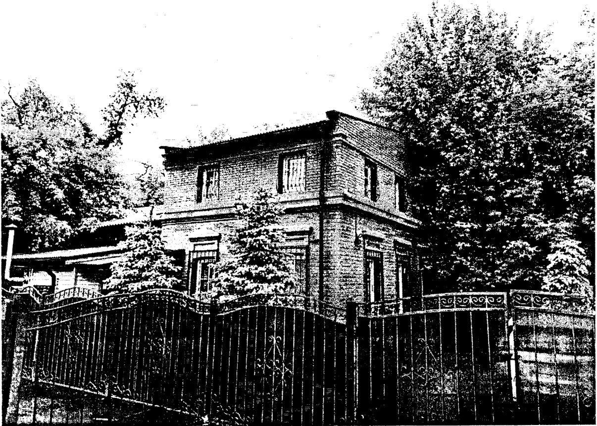
Фотография № 4. Вид на объект культурного наследия
