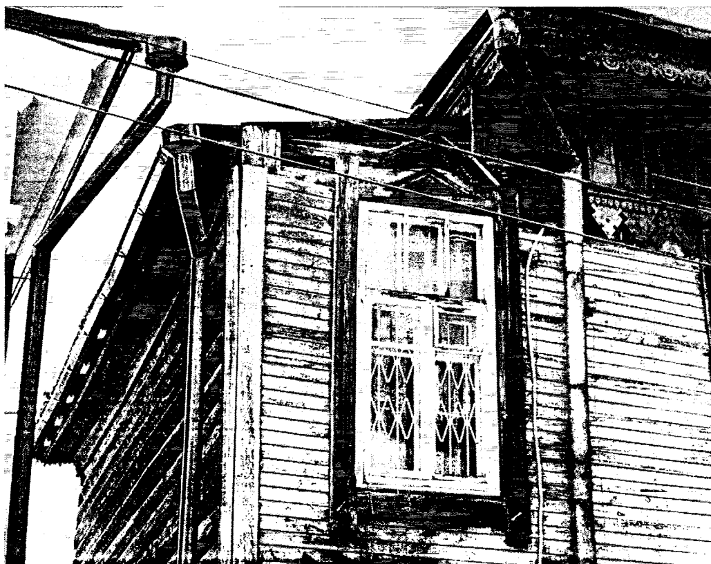
Фотография № 4. Вид на фрагмент объекта объект культурного наследия
