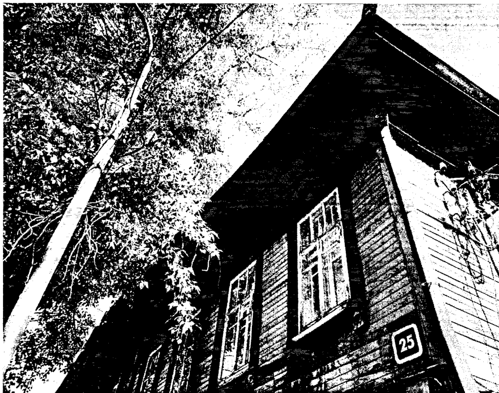
Фотография № 3. Вид на фрагмент объекта объект культурного наследия
