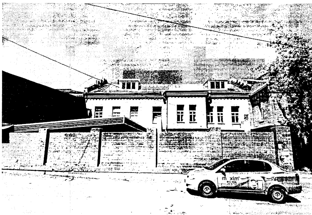
Фотография № 2. Вид фрагмент фасада объекта культурного наследия
