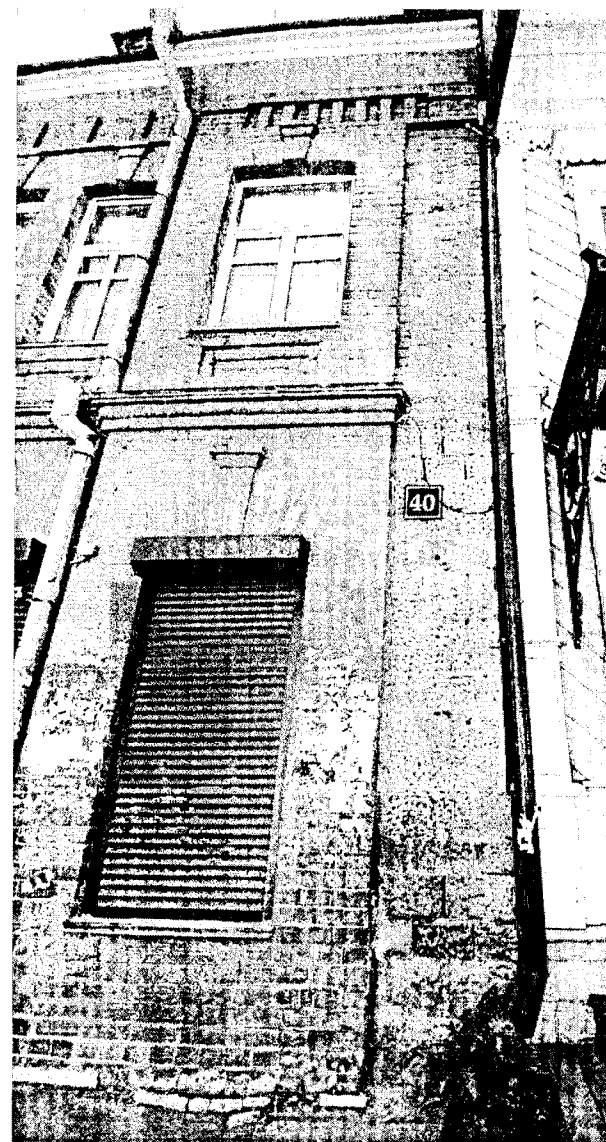
Фотография № 4. Вид фрагмент фасада объекта культурного наследия
